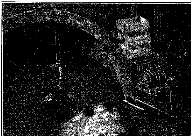
Curage d'un canal en tunnel par SCRAPER PIC ABO alimentant une benne
