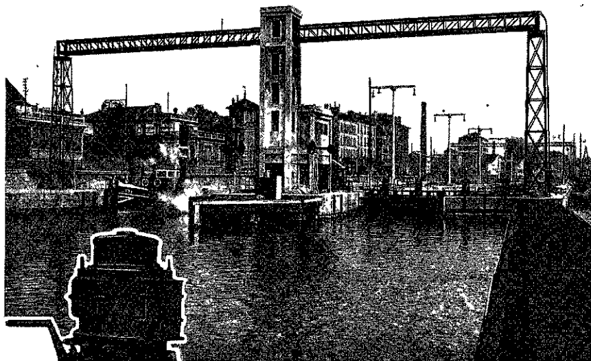
ÉLECTRIFICATION de l'Ecluse de Suresnes.
