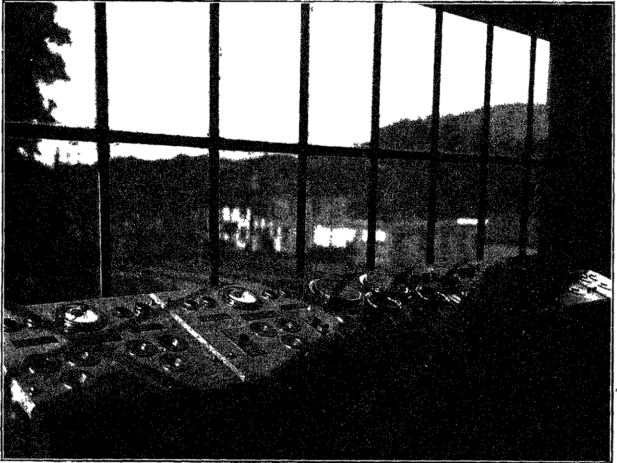
Pupitres de commande des portes et vannes
