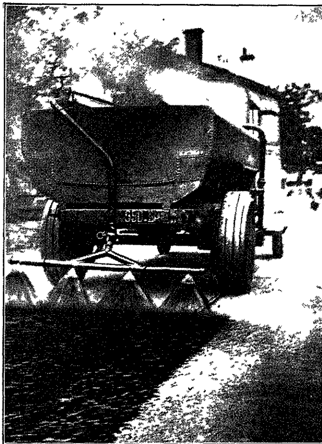
Répandage de GOUDRON-BITUME.
