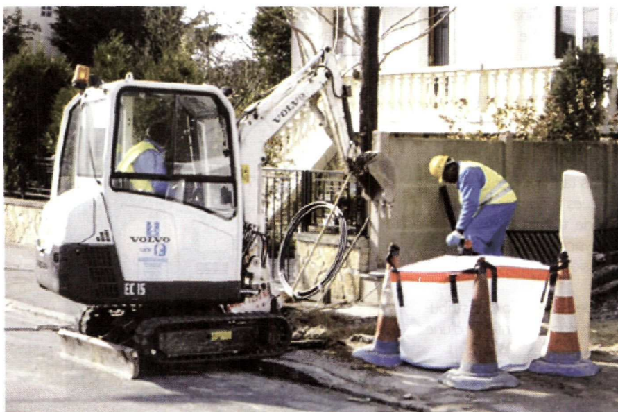
Pose d'un branchement neuf
