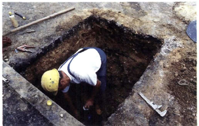
Réparation d'une fuite
