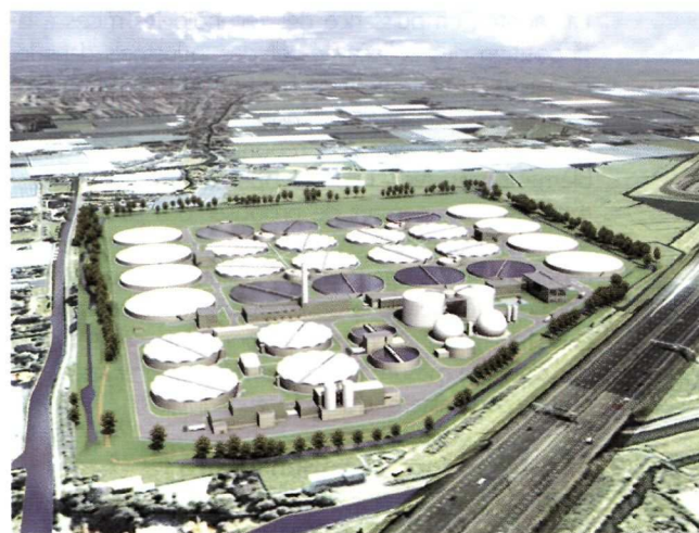
Usine de dépollution des eaux usées d'Hamaschpolder. Construction pour 2008 de la plus grande usine de dépollution répondant aux dernières normes européennes (Consortium franco-néerlandais conduit par Veolia Water) - Pays-Bas
