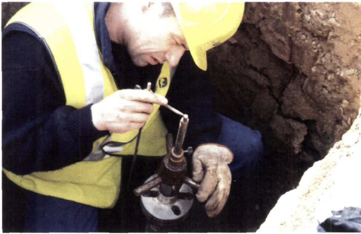
Prise en charge sur une canalisation
