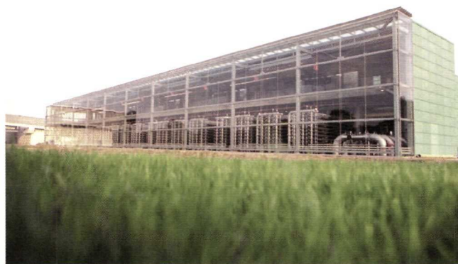
Usine de production d'eau potable de Méry-sur-Oise utilisant la nanofiltration, l'une des technologies les plus avancées à ce jour.
