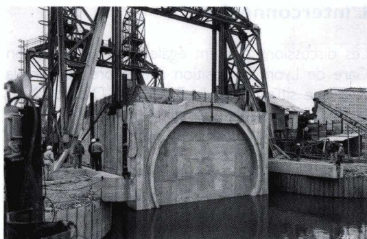
Caisson immergé dans la Seine à Neuilly
