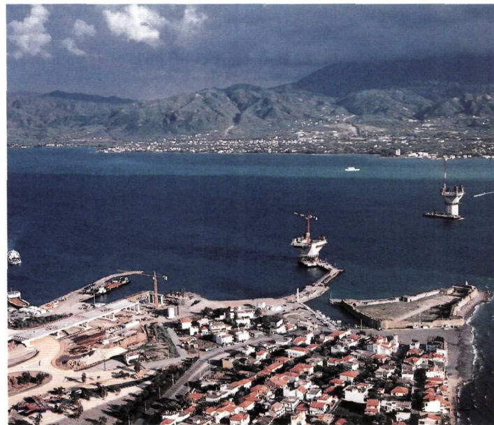
Fig. 1 - Le site du pont : on voit émerger les quatre piles (septembre 2002).
