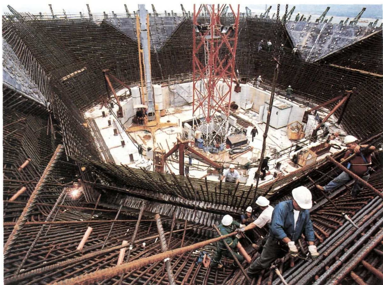
Fig. 7 - Vue du chapiteau d'une pile.
