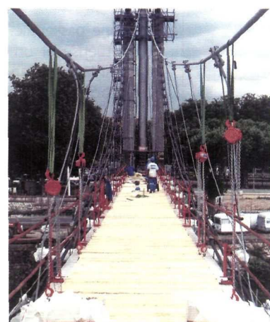
Agen, nouveau tablier sur ancien
