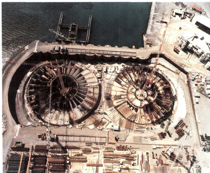
Fig. 5 - Vue de la cale sèche avec deux embases en cours de construction.
