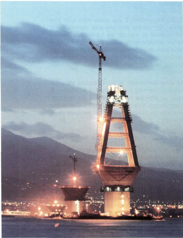
Fig. 4 - Construction des pylônes.
