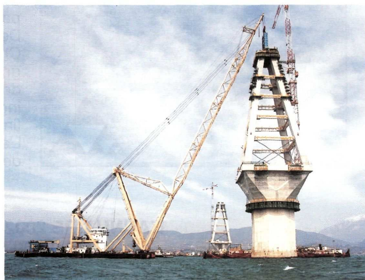
Fig. 8 - Mise en place de la tête de pylône métallique.
