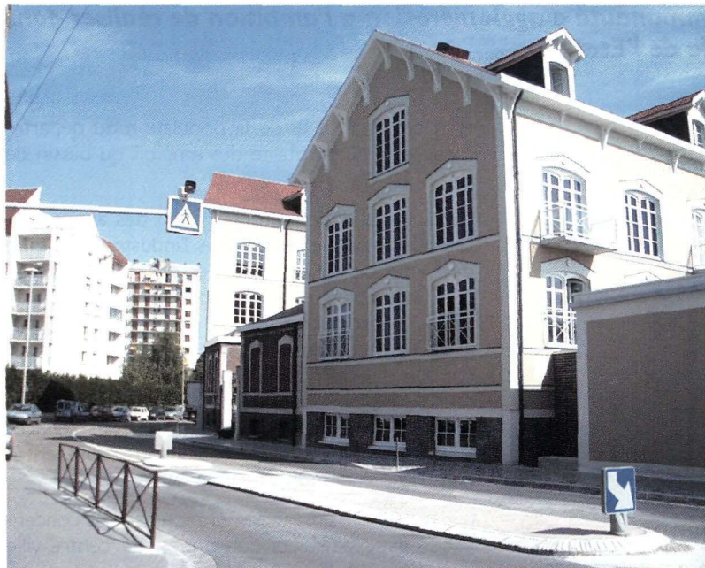
Réhabilitation friche Poron hôtel Mercure.
