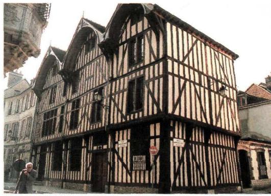
Réhabilitation rue du Vauluisant.
