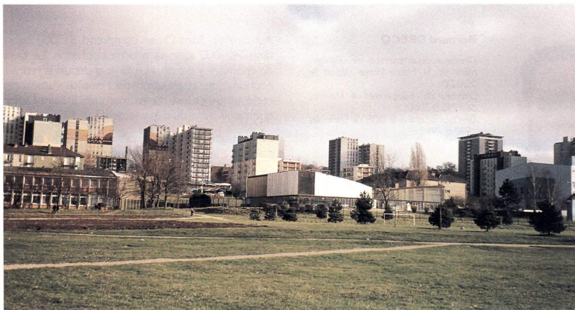
Le Vert Bois : vue générale.
