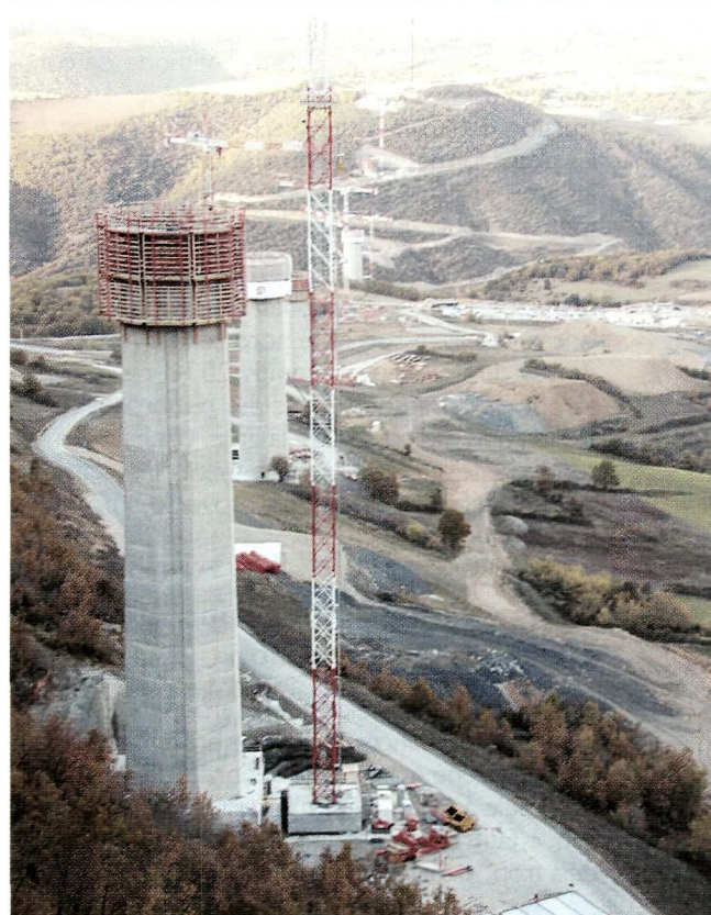
Vue générale du chantier
