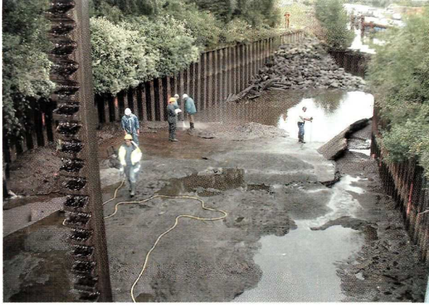
Inspection du radier du barrage de Quesnoy à reconstruire pour en augmenter la capacité.
