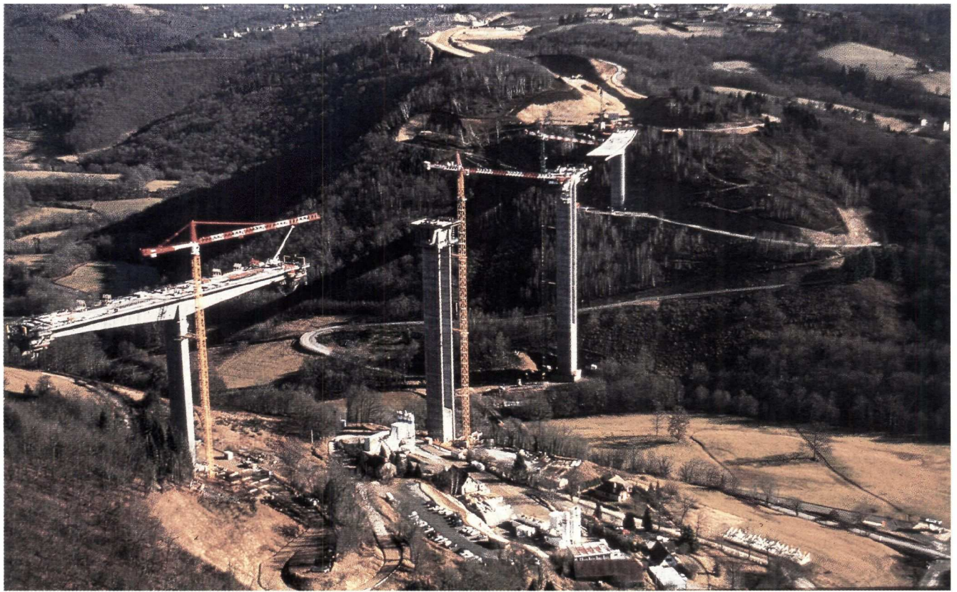
ASF doit encore construire 318 km : ici le viaduc de Tulle sur la A89 Bordeaux-Clermont-Ferrand.
