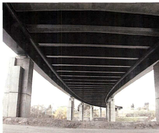
Viaduc en construction sur le contournement ouest de Maubeuge.
