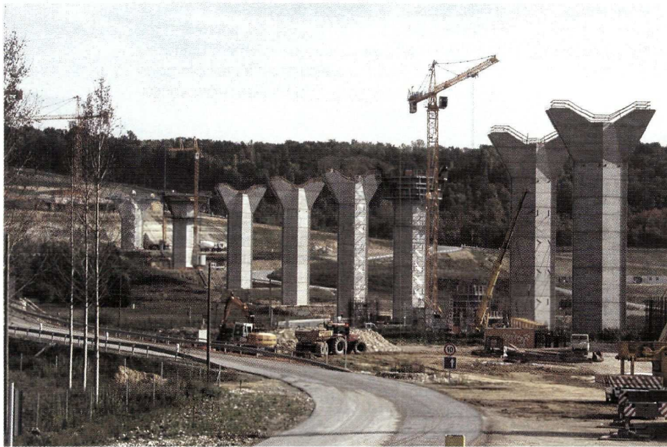
Vue d'ensemble montrant l'avancement du chantier des piles en octobre 2002.
