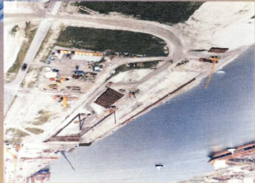
Extension "Quai de Flandre" - Dunkerque - FRANCE
