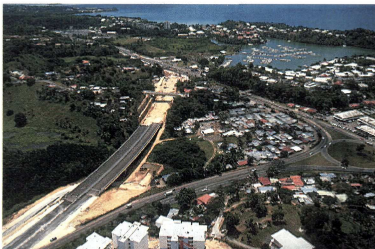
RN 4, construction de la déviation de Blanchard, à proximité du carrefour de la Marina qui accueillera en fin d'année la Route du Rhum.
