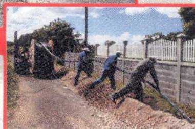
POSE DE CABLES
