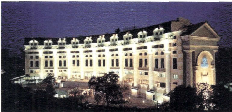
Hôtel Hilton - Hanoi Conception-construction de 65 M$
