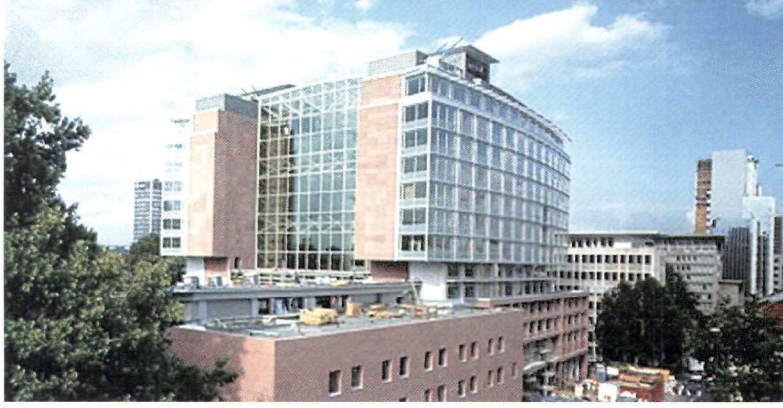
Hôtel Hilton - Frankfurt Conception-construction de 176 MDM
