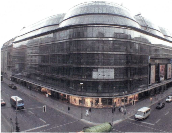
Immeuble de bureaux et Galeries Lafayette Conception-construction de 216 MDM
