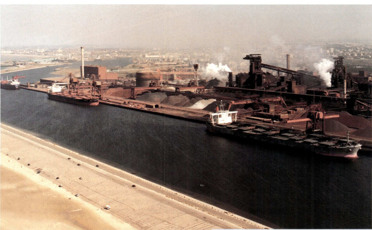
Le quai minéralier de l'usine SOLLAC à Dunkerque. L'activité vrac est étroitement liée aux implantations industrielles.
