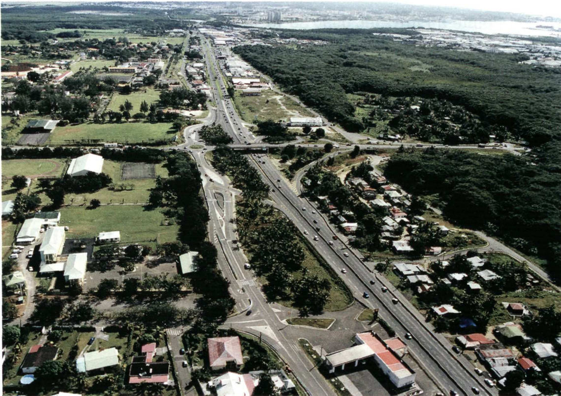
RN 1 : Commune de Baie-Mahault - Chantier de mise à 2 x 3 voies entre les échangeurs de Destrellan et de la Jaille avec pose d'écrans acoustiques côté sud. Au premier plan, il s'agit de l'échangeur de la Jaille où débute la rocade nord de Pointe-à-Pitre. En arrière-plan, on distingue Pointe-à-Pitre et le plan d'eau du port.
