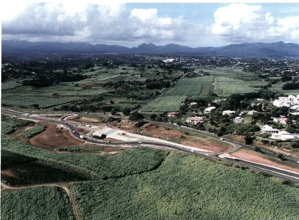
RN 1 : Pointe-à-Pitre / Basse-Terre, échangeur de Versailles (accès à la côte sous le vent via la Route des Mamelles, celles-ci sont visibles en arrière-plan), travaux en cours, achèvement prévu au 2 e trimestre 2001.
