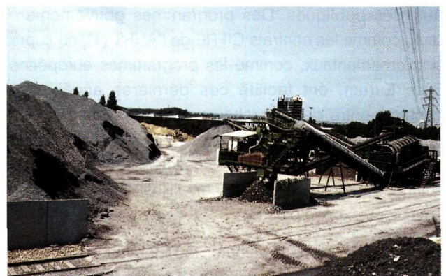
L'installation de traitement des mâchefers de l'entreprise Jean Lefebvre à Saint-Ouen-l'Aumône.
