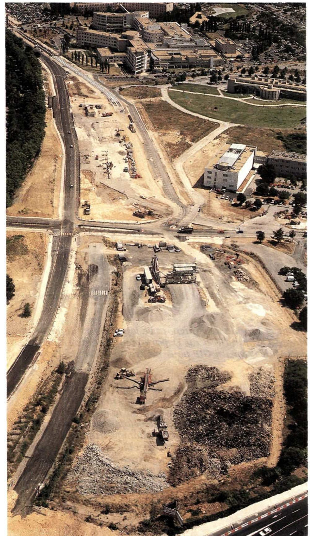
La plate-forme de recyclage des matériaux de déconstruction du tramway de Montpellier.
