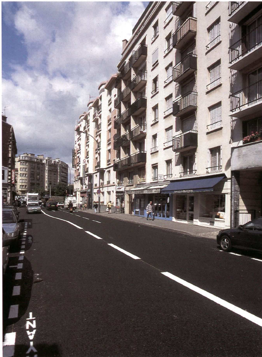
Chantier Colsoft - Boulogne-Billancourt.
