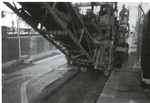
Rabotage de la structure bitumineuse dégradée.
