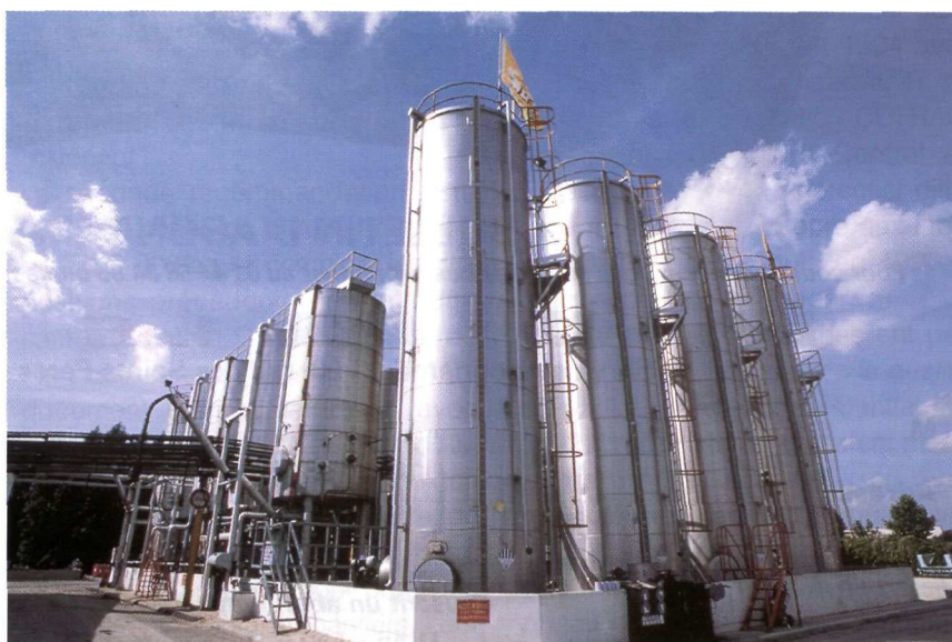
Usine de liants de Troyes, qui vient d'être certifiée ISO 9002 en septembre 98.
