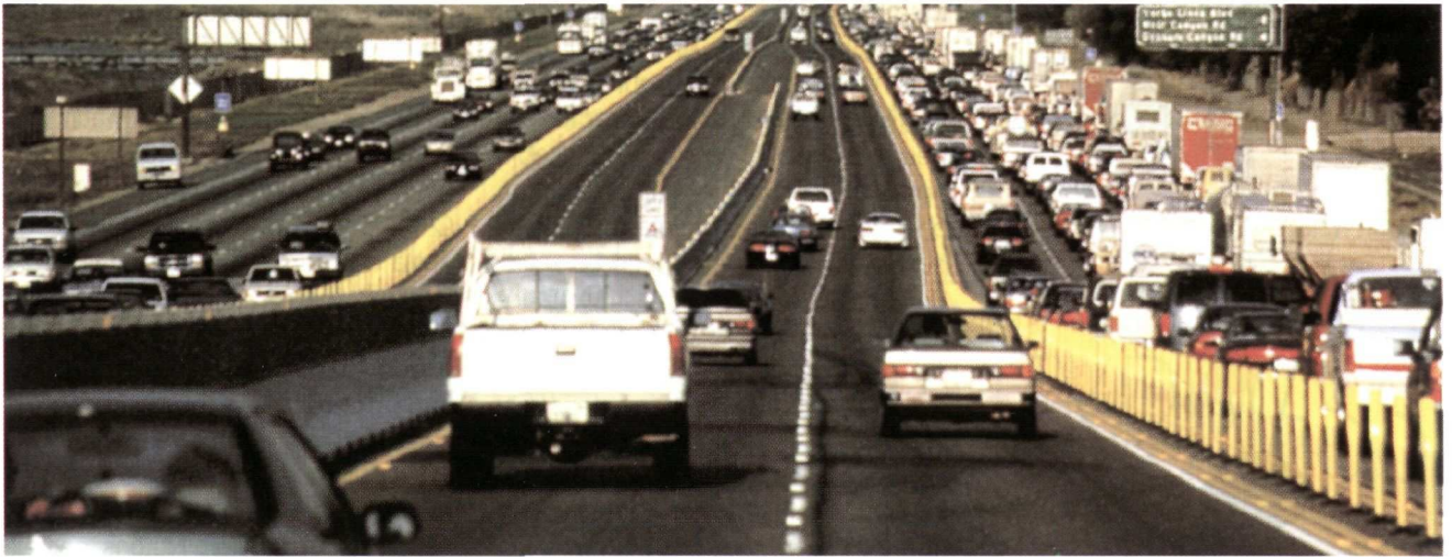
L'ouvrage : deux voies ont été construites dans chaque sens, sans accès intermédiaire. Elles sont séparées de l'autoroute gratuite par des balises en plastique et une signalisation horizontale.
