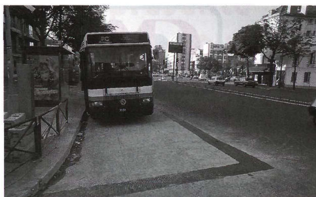
Arrêt de bus réalisé en BCMC Boulevard Davout à Paris 12 e .
