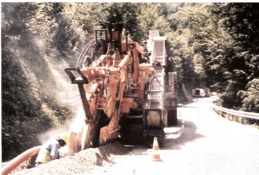
Installation de câbles EDF en Savoie par l'entreprise Gauthey, première filiale du Groupe certifiée ISO 9002 en 1997 pour l'ensemble de ses activités.
