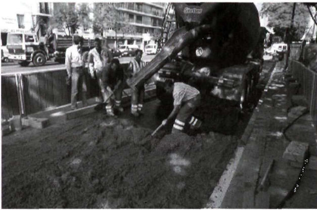
Mise en œuvre du BCMC sur l'arrêt de bus Boulevard Davout à Paris 12 e .
