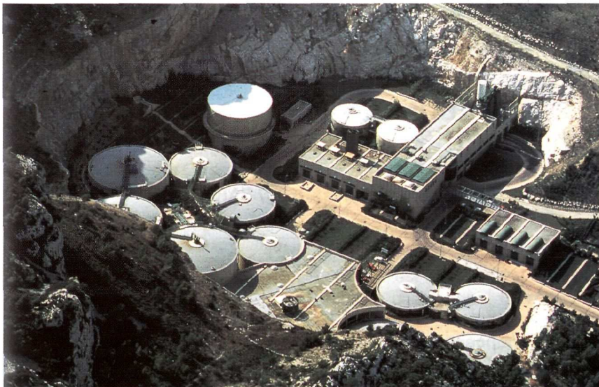
Usine de traitement de boues de Marseille.
