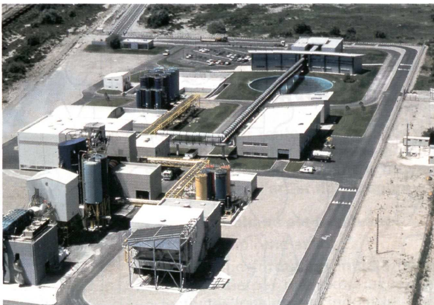
Incinération avec valorisation énergétique. SOLAMAT-MEREX - Fos-sur-Mer (13) - Groupe SARP Industries.
