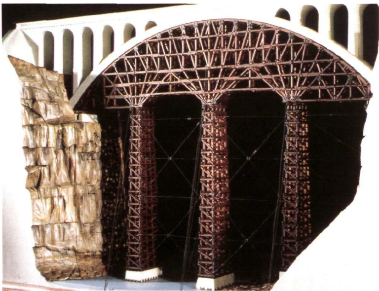
Cintre de construction du viaduc de Bellegarde (Ain) construit en 1911.
