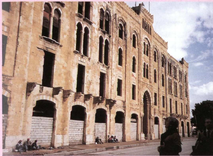
Ancien Hôtel de Ville en rénovation - Beyrouth.
