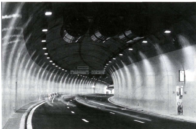
Lyon : tunnel de la Duchère.
