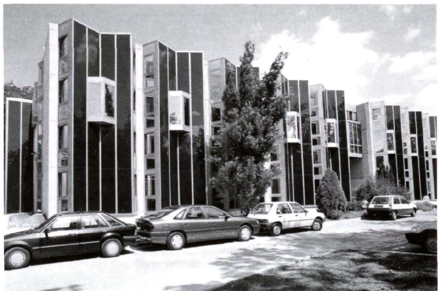
Mondialement connu, le Centre de Recherche de Maisons-Laffitte est devenu un des acteurs majeurs de la Recherche du Groupe Générale des Eaux, dans le domaine de l'eau. (Doc. Anjou Recherche).
