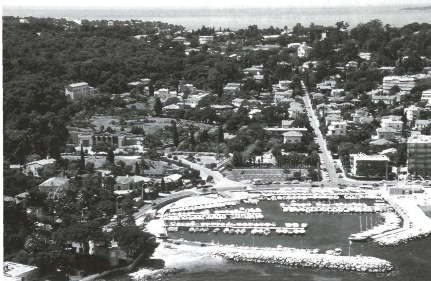
La station d'épuration d'Antibes : vue générale aérienne. (Doc. OTV - Cie Générale des Eaux).
