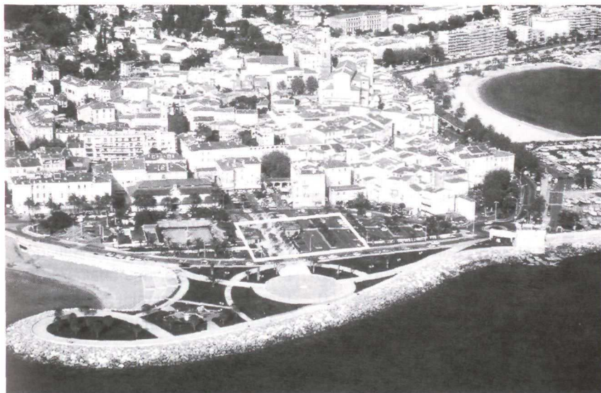
La station d'épuration de Menton : vue générale aérienne avec périmètre de l'ouvrage. (Doc. OTV Cie Générale des Eaux).
