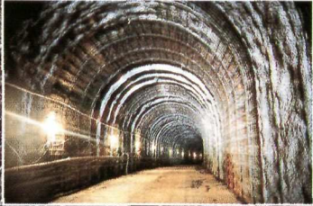
Tunnel d'accès creusé dans la falaise.
