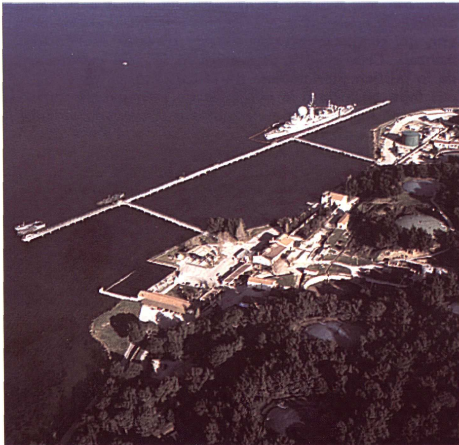
Le parc à combustible du Lazaret dans la rade de Toulon.
