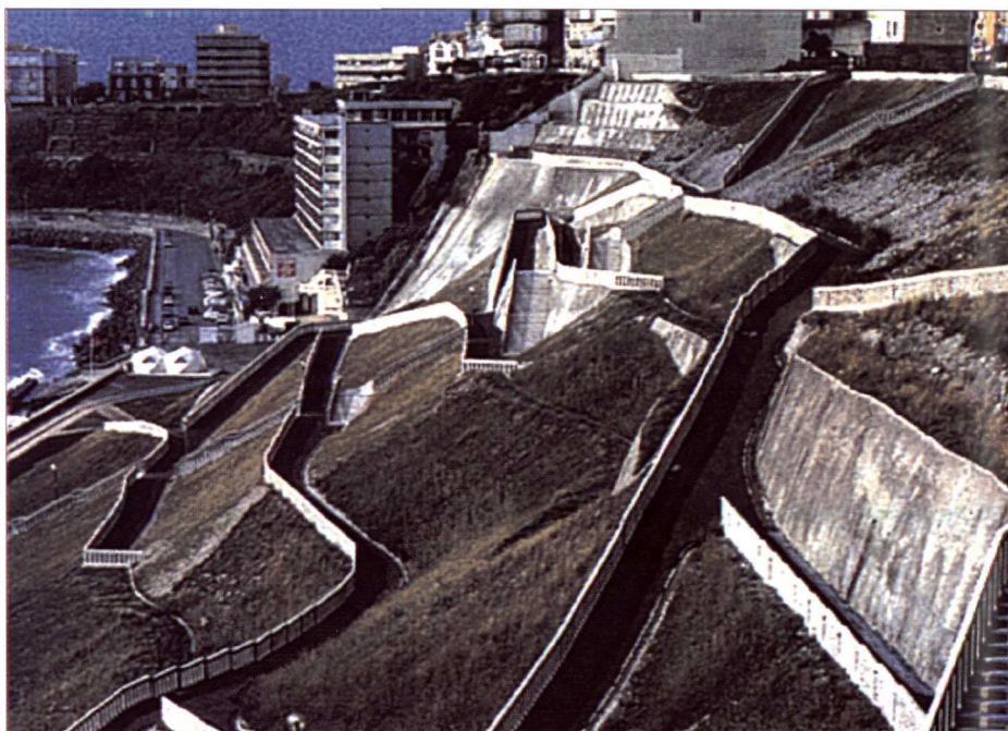
Confortement des falaises de la côte basque à Biarritz (Pyrénées Atlantiques). Bilan des travaux réalisés entre 1983 et 1992.
