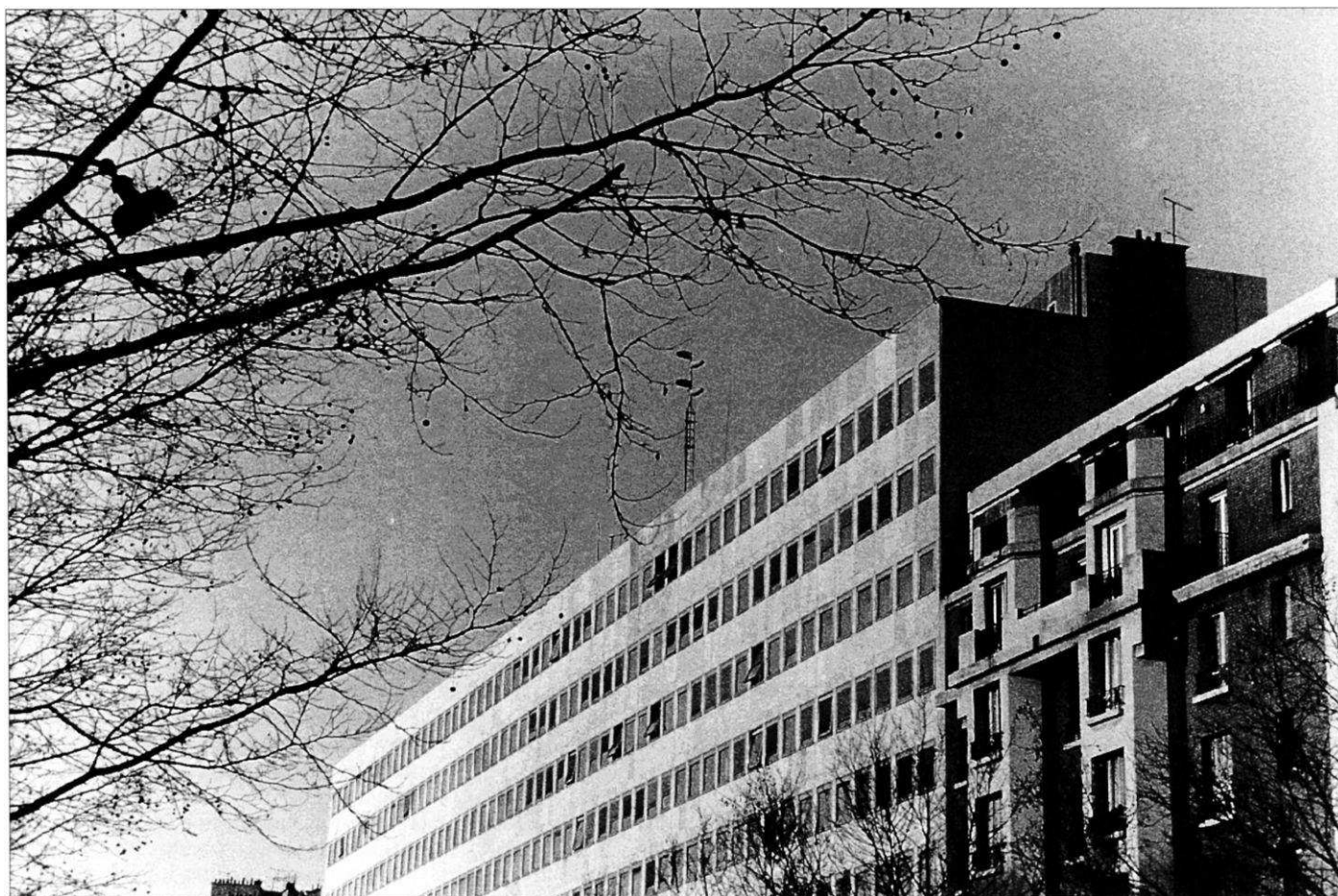
Antennes directives à 90° (2 directions différentes), immeuble SFR, boulevard Brune, Paris XIV e .
