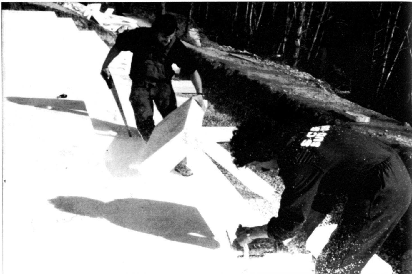
Remblais léger compostyrène.
