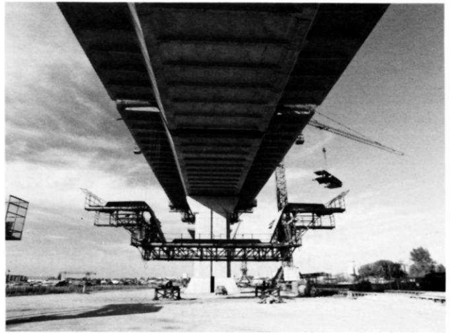
Introduction du tablier - Coffrage de l'équipage de clavage.
