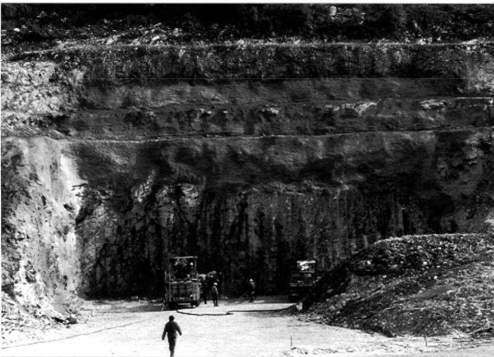
Terrassement de la tête Nord du tunnel.
