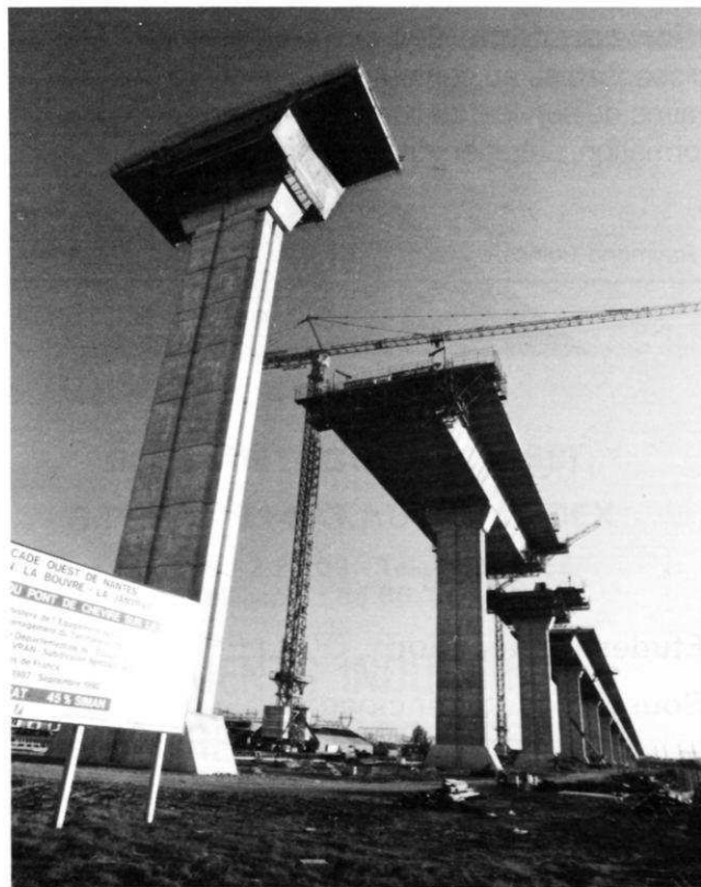
Equipage de voussoir à hauteur variable.
