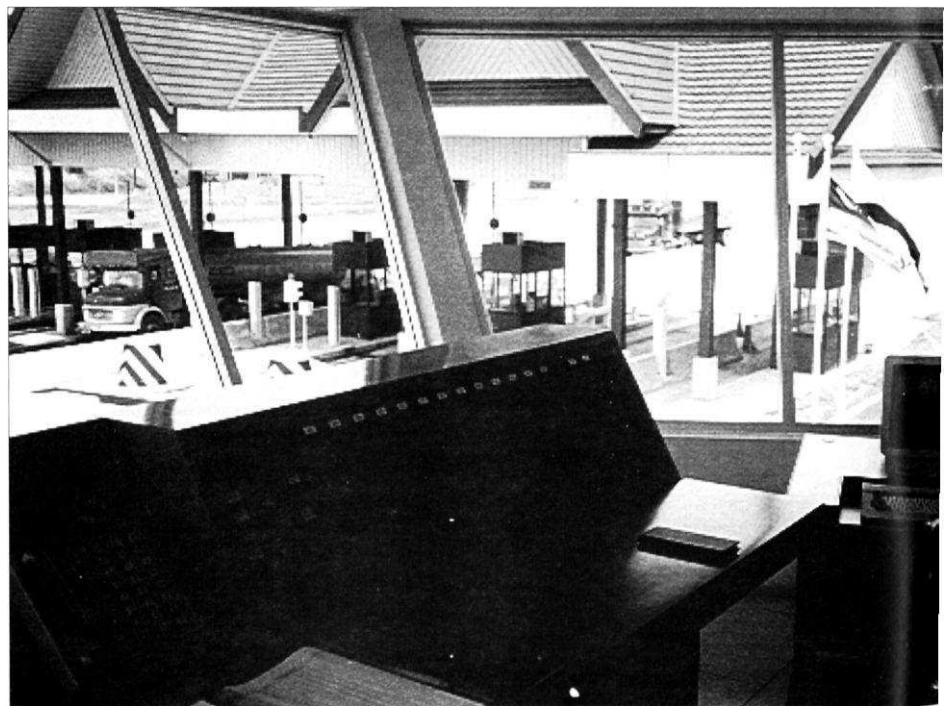
Gare de péage de Jelapang vue de la salle de supervision.
