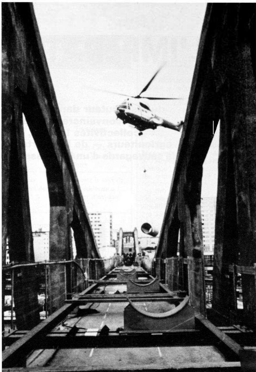
\* Chantier de doublement de la liaison "Marne-Seine" : mise en place par hélicoptère des éléments de la conduite de  $\varnothing$  1250 en acier entre Ivry et Charenton (photo Syndicat des Eaux d'Ile-de-France).
