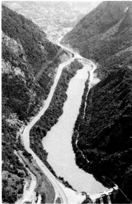
Gorges de Ponserand (percement d'un tunnel).
