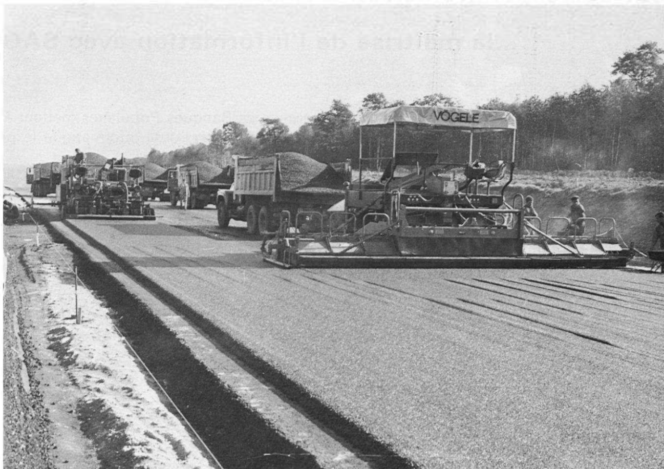
Atelier d'application de matériaux enrobés
