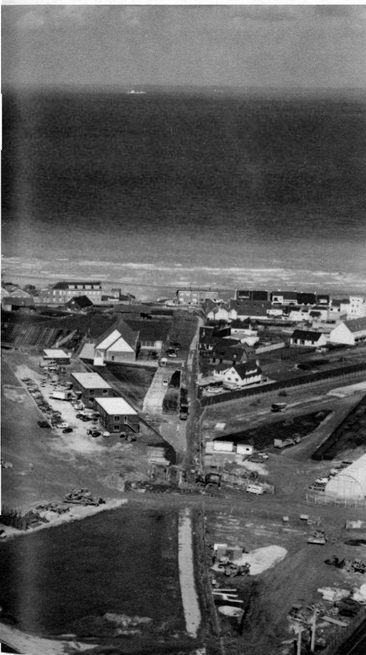
Chantier du tunnel sous la tranche à Sangatte. Phot'R.
