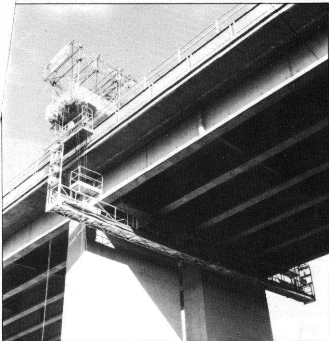
Réparation et mise en peinture du viaduc de Rive-de-Gier
