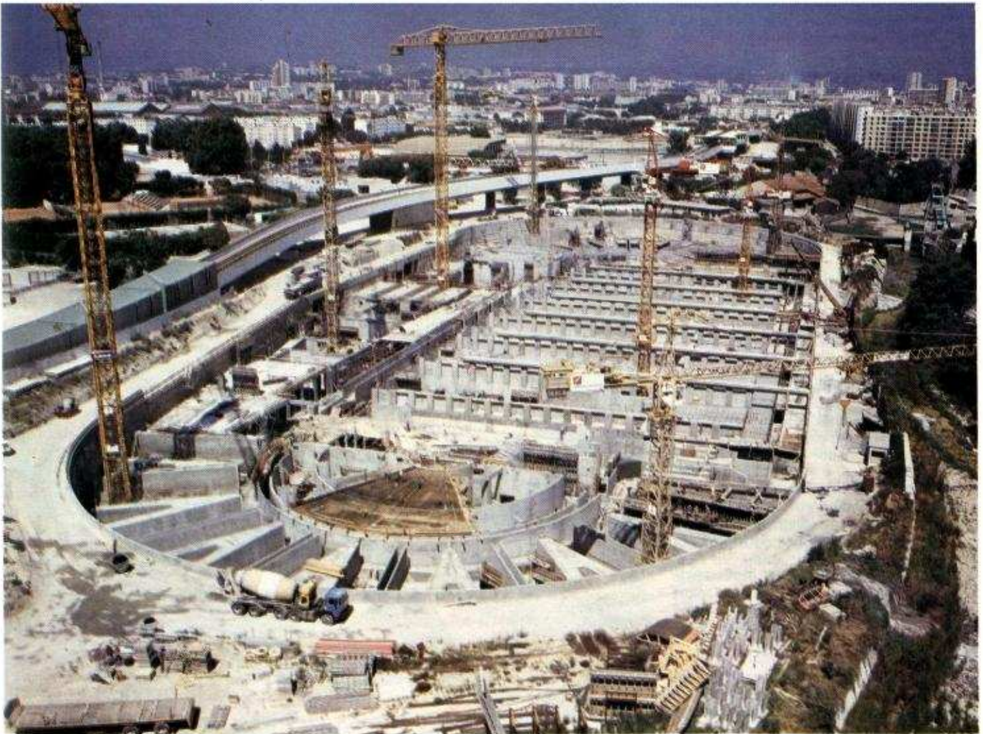
Vue générale de l'usine
