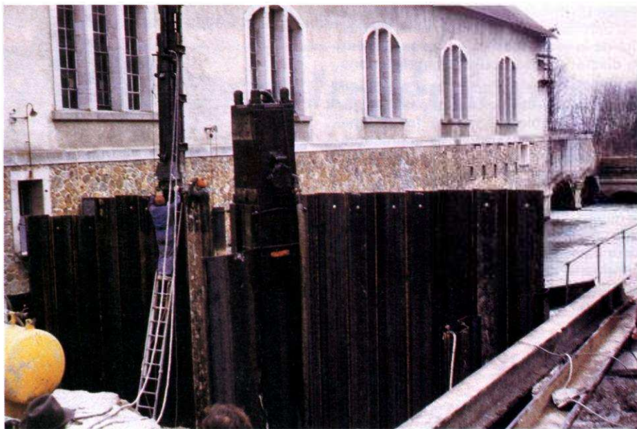
1984. Construction de la nouvelle station de pompage entre les deux bâtiments
