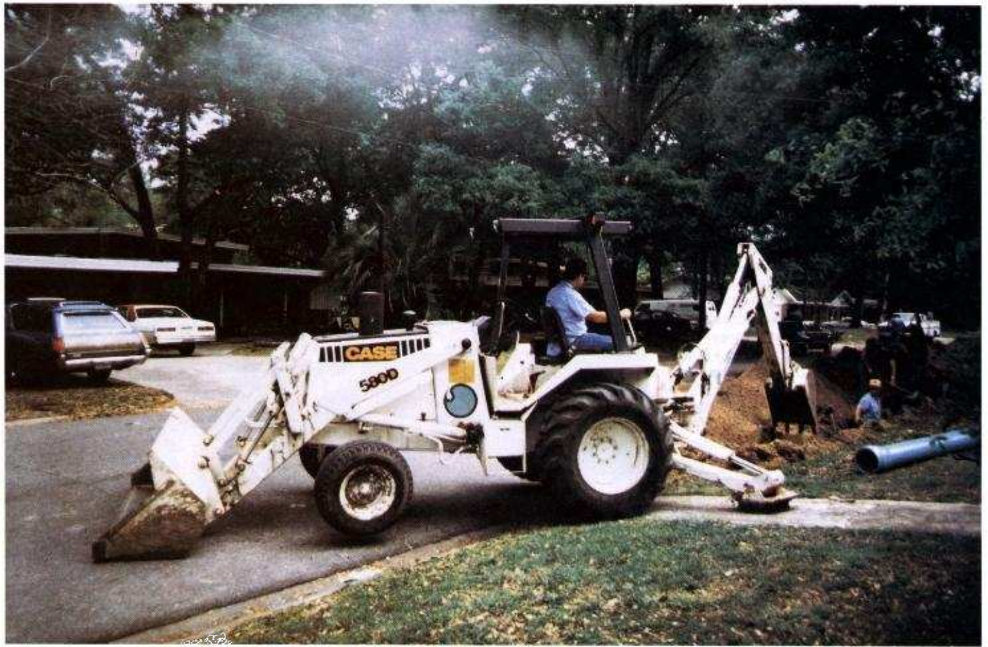
Pose de canalisations PVC à Jacksonville (Floride)
