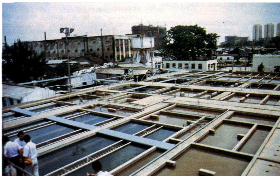
Façade du laboratoire d'analyses. Installation de traitement d'eau de Macao
