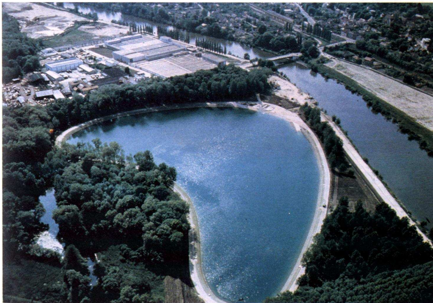
Vue aérienne d'un bassin de stockage
