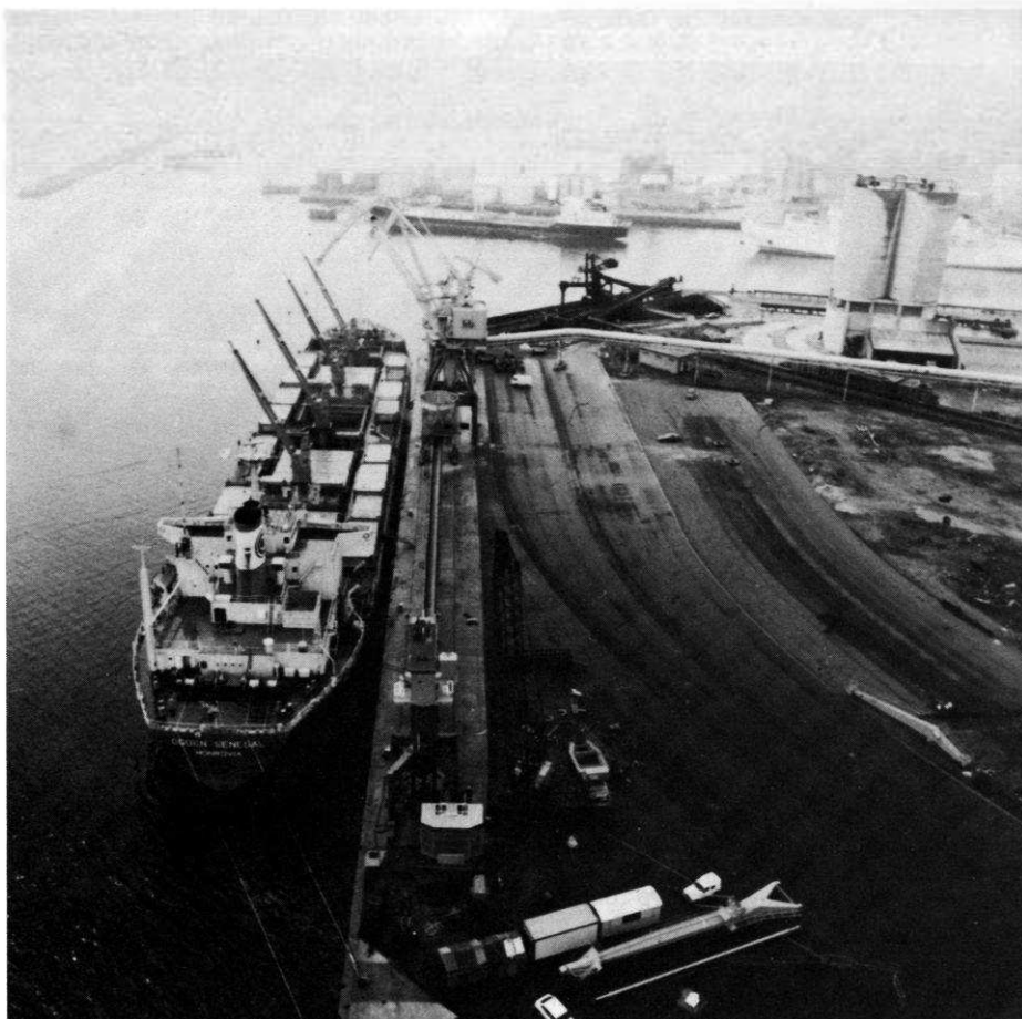
Port de Brest 6 e quai Sud : déchargement d'un bateau de graines de soja sur le tapis de liaison avec les silos. Au premier plan, montage d'une grue.
