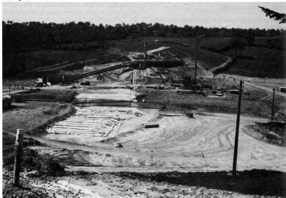
Barrage principal - juin 1982.
