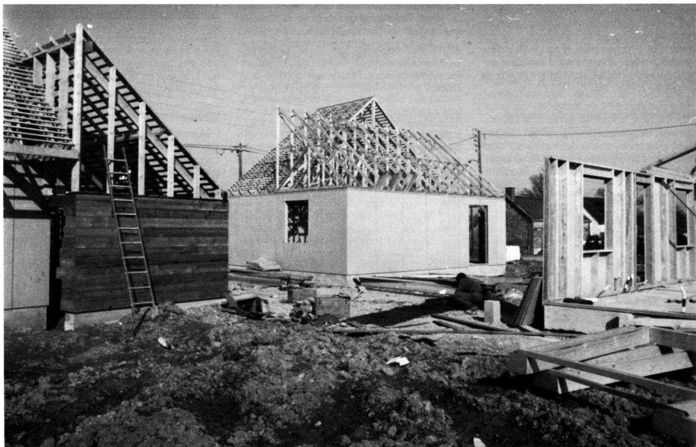
Maison à ossature de bois à Torcé. Maître d'ouvrage : office départemental d'HLM.
