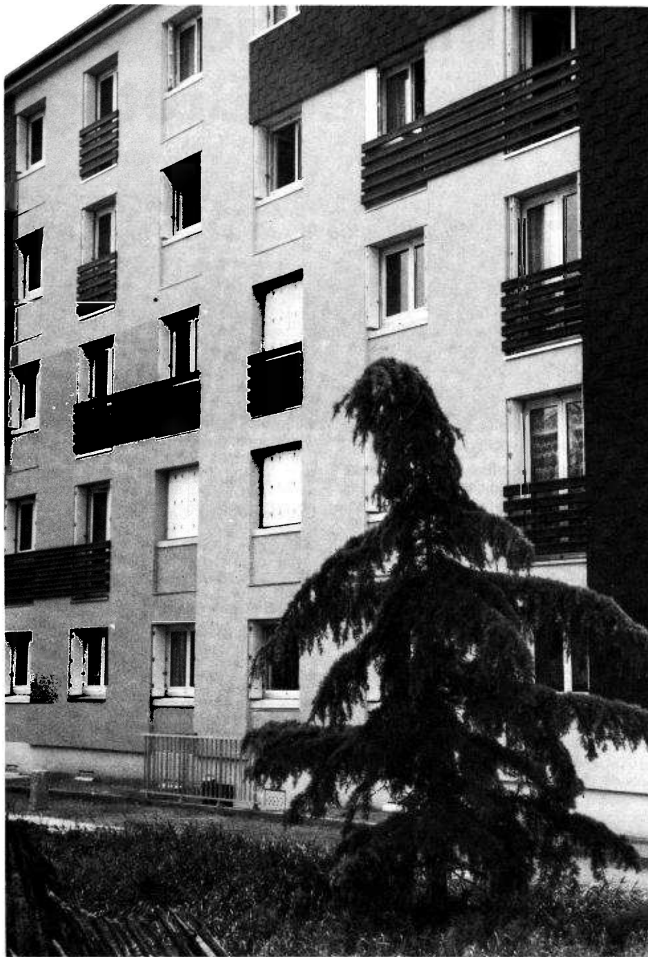
Réhabilitation de Bel Air à Rennes. Maître d'ouvrage : SA d'HLM Aiguillon-Construction.
