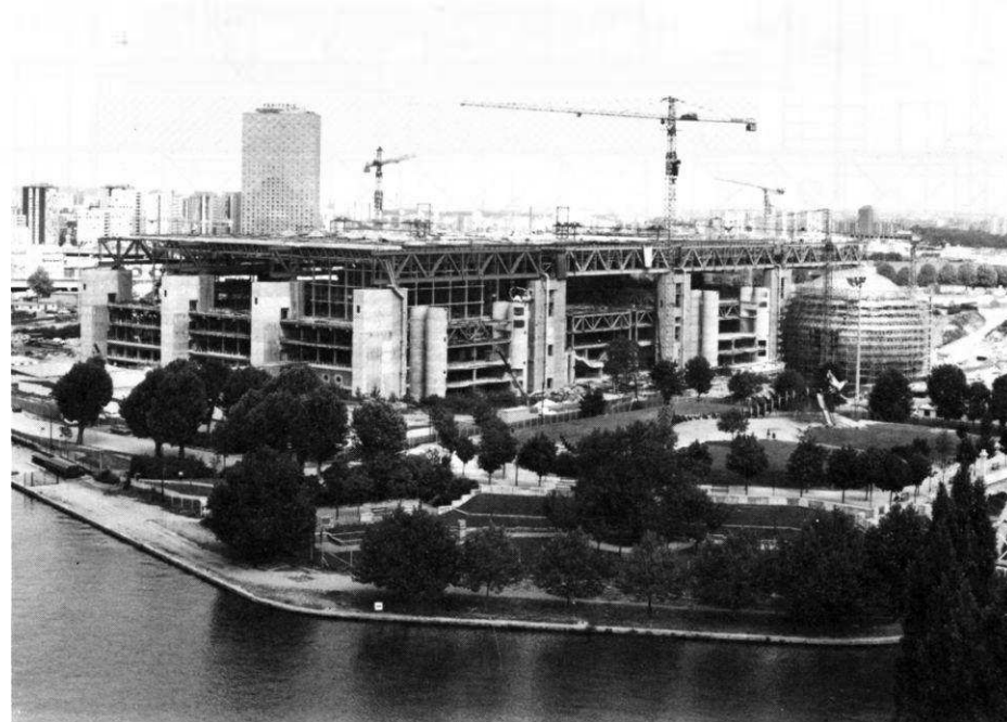
Vue générale du chantier en janvier 1984.
