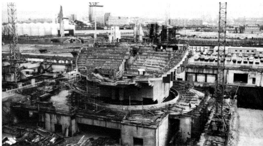
On distingue les gradins et la poutre circulaire en béton qui recevra la sphère.
