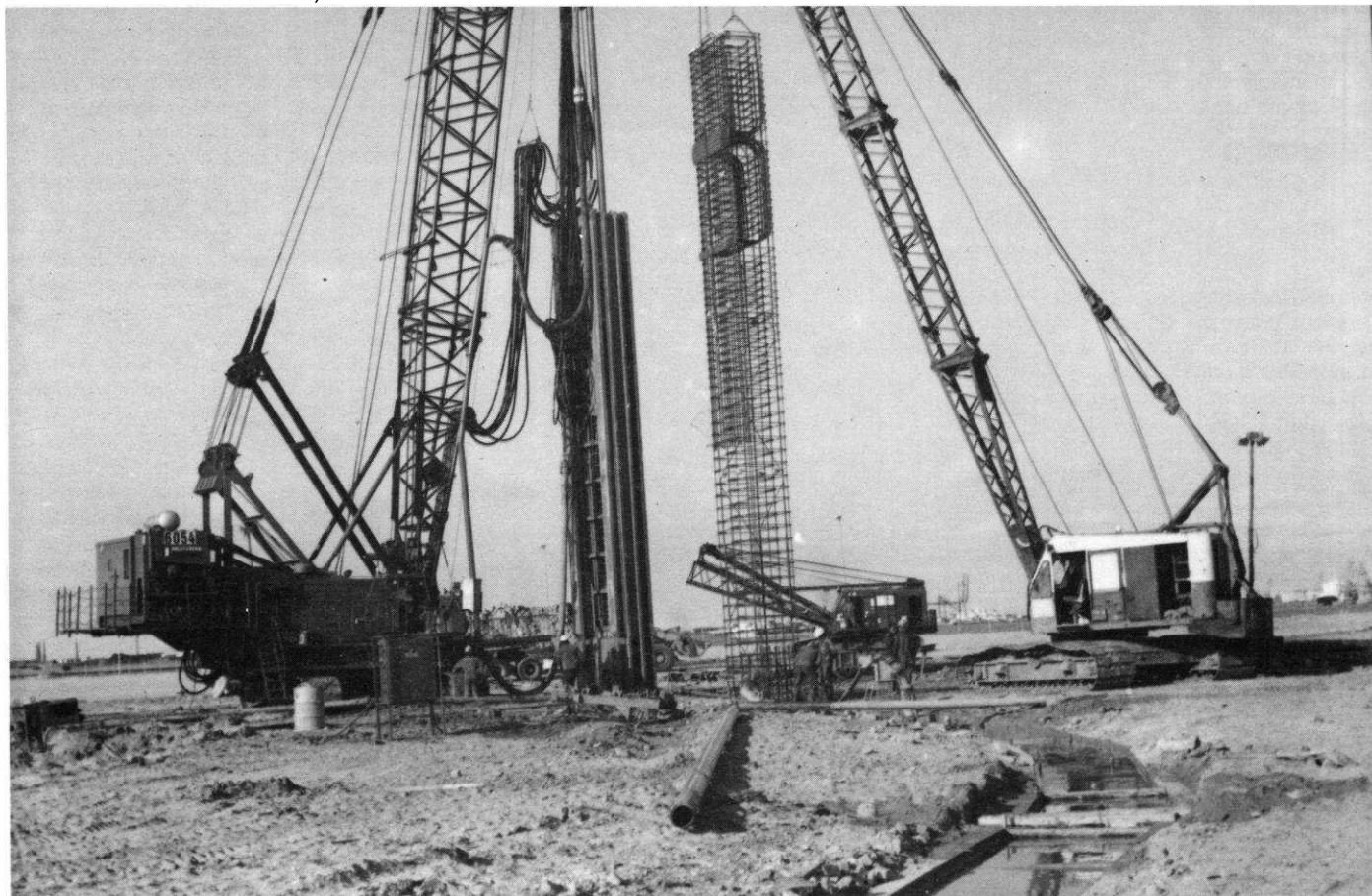
Cliché 1 — Vue d'un chantier Hydrofraise.
