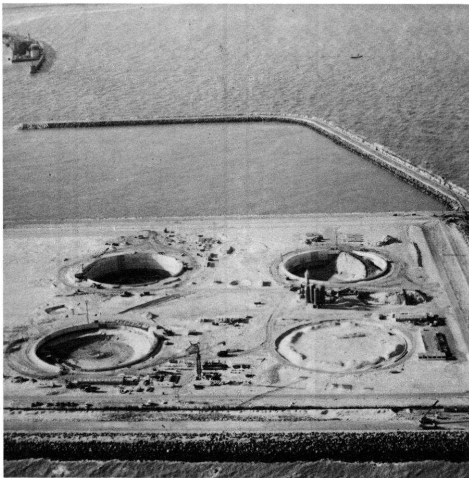
Cliché 2 — Vue aérienne des réservoirs de Zeebrugge en cours de terrassement.
