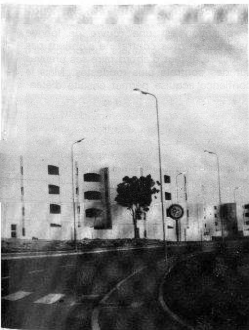
étés en groupes compacts autour d'une cour intérieure
