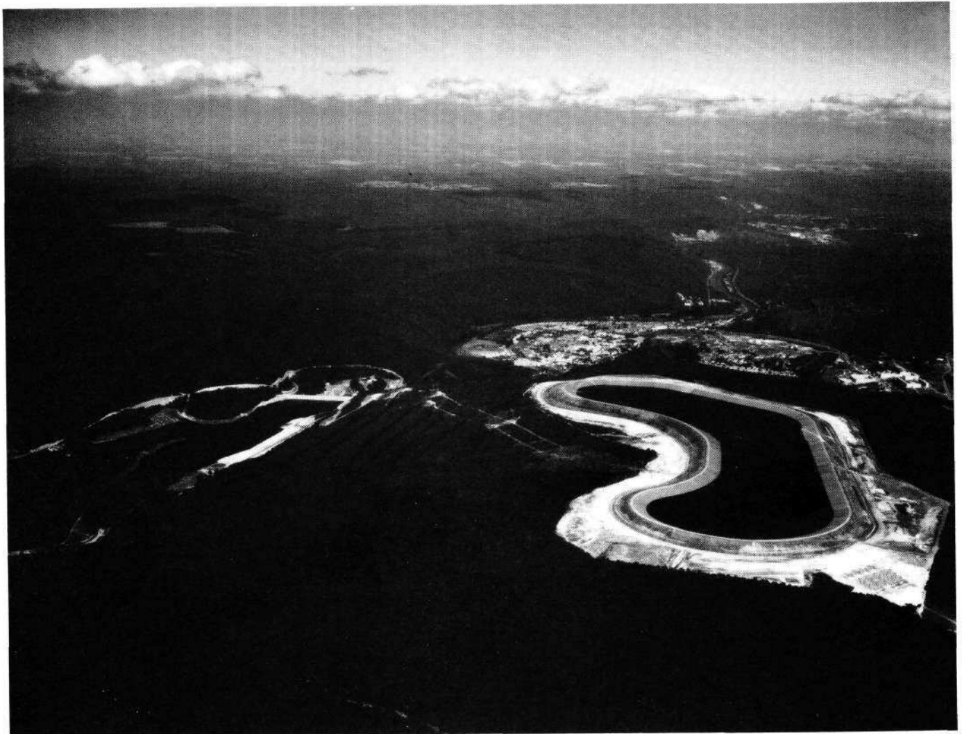
Station de pompage de Revin (Ardennes)
