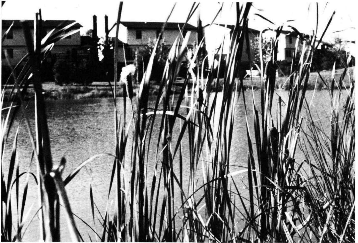
Bassin d'orage en Virginie bien intégré dans l'urbanisme, on distingue des joncs qui contribuent à réduire la pollution des eaux de ruissellement. (Photo J. Cheron).
