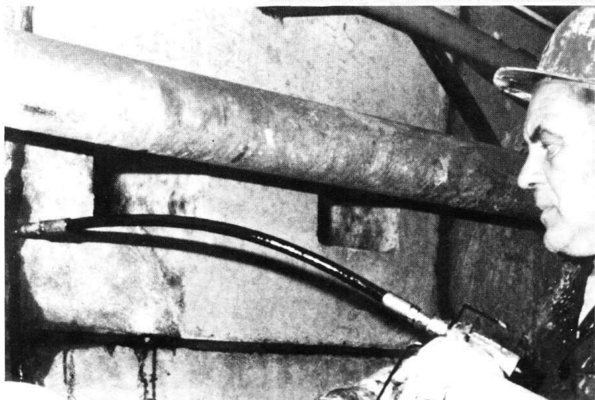
Injection de fissure dans une structure en béton précontraint.
