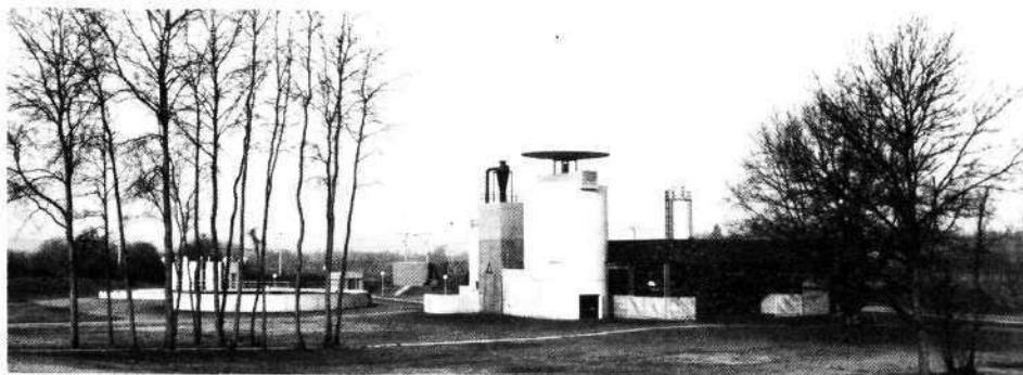
Vue générale de la station d'épuration.
