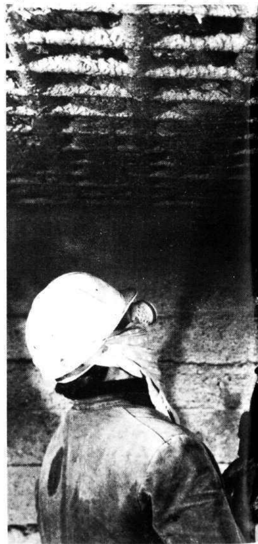
Réparation en cours d'un bandeau par projection
