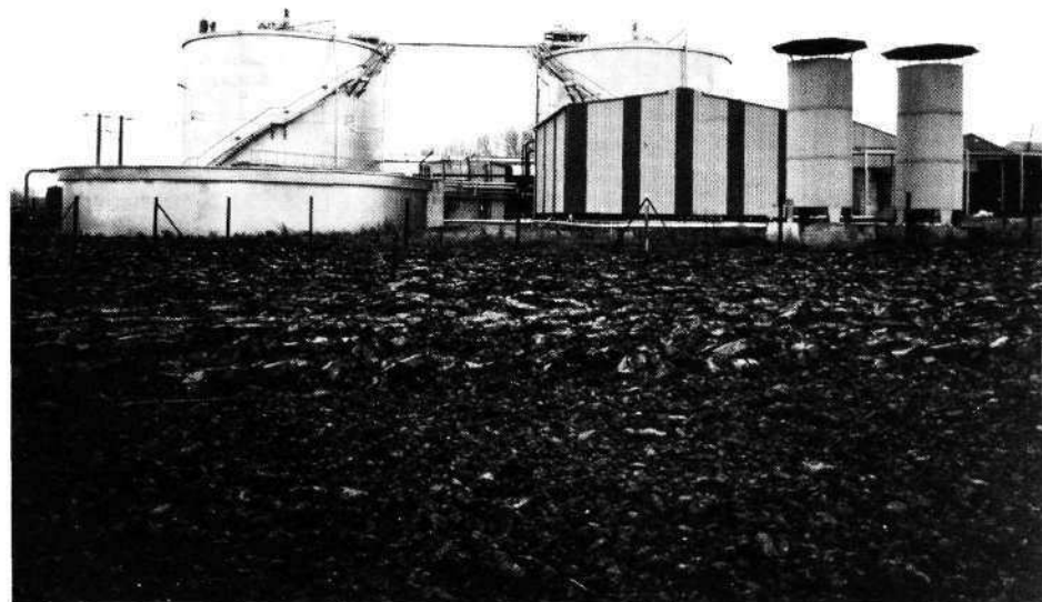
5 - Installation pilote de méthanisation d'eaux résiduaires urbaines au Laboratoire Central de la Lyonnaise des Eaux.
