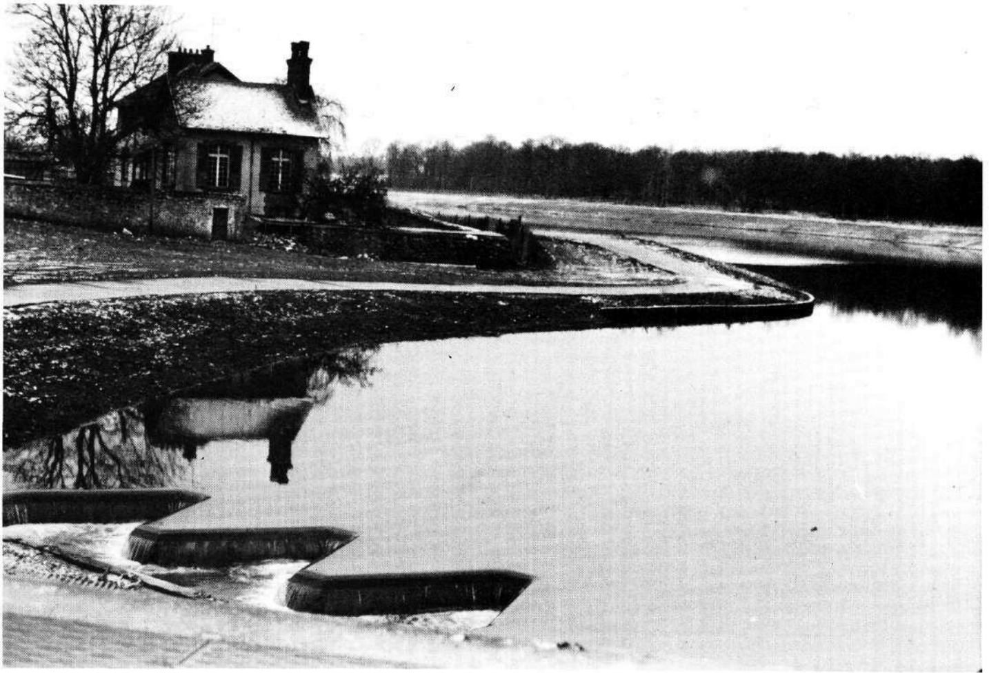
Bassin d'orage à Marne-la-Vallée (Photo STU), on distingue au premier plan le déversoir.
