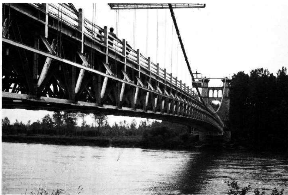
Poutre de rigidité en aluminium du pont de Groslée.
