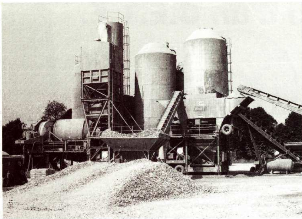
Autoroute A 26. Une des centrales à béton. Le silo le plus haut contient des cendres volantes.
