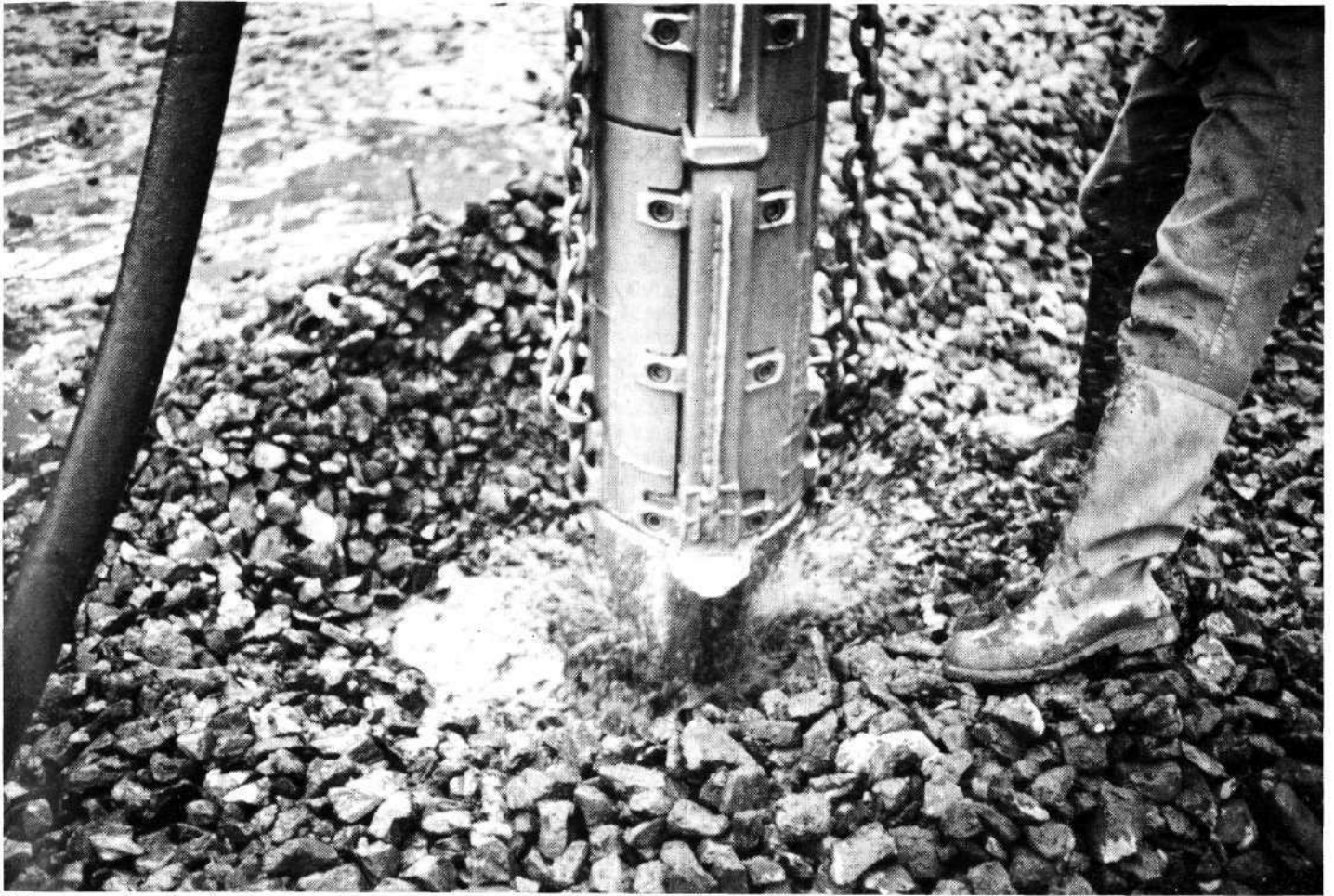
Traitement de sol par colonne ballastée.
