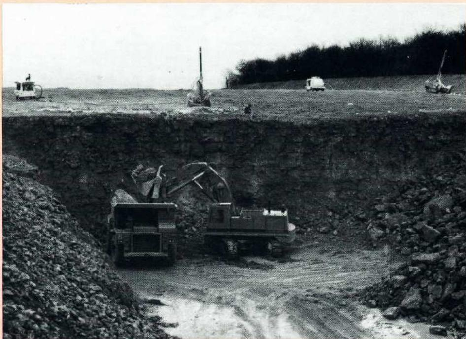
Réalisation du déblai rocheux dans la butte de Foug (pelle CAT 245 et tombereaux CAT 773 B de 50 t de charge utile).
