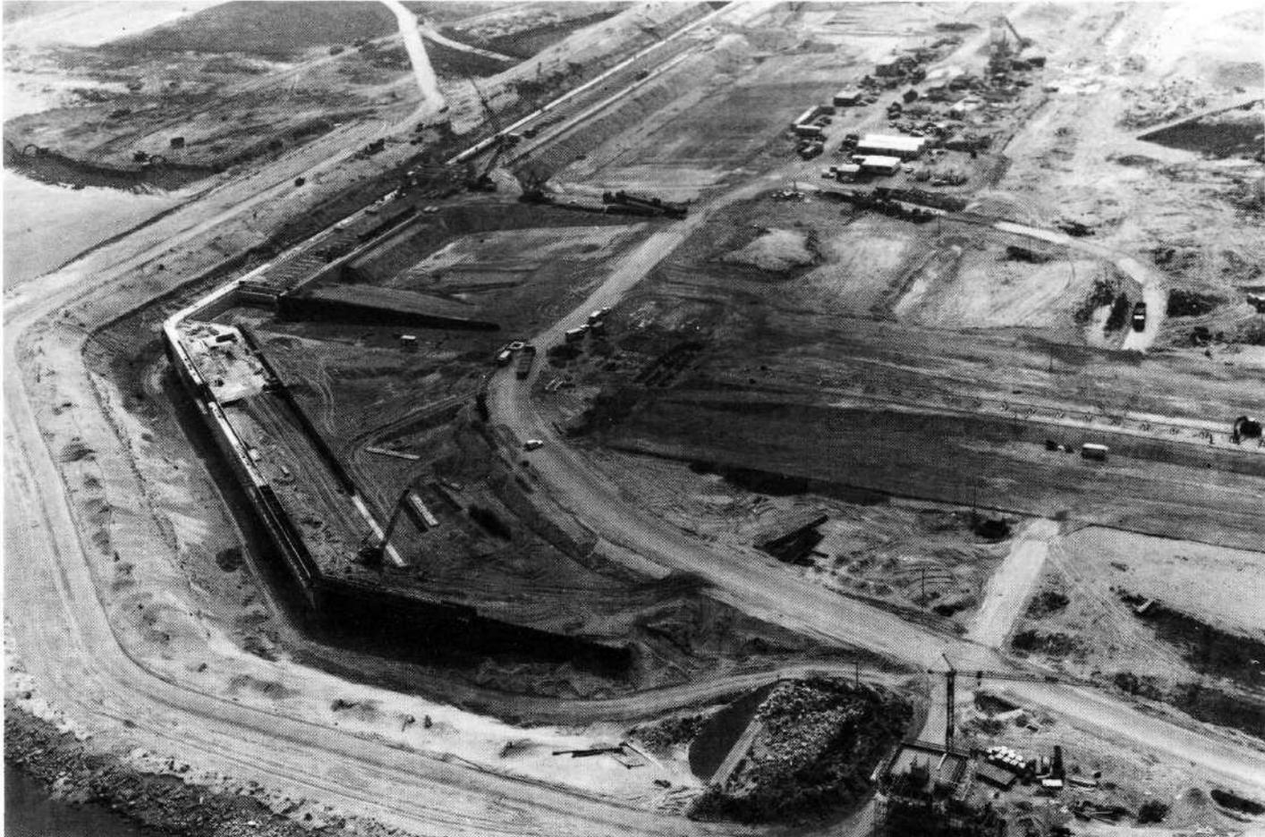
Port Ouest : chantier de construction du terminal à pondéreux, accessible aux vraquiers de 180 000 tonnes en phase 1 dès sa mise en service (janvier 1983).
