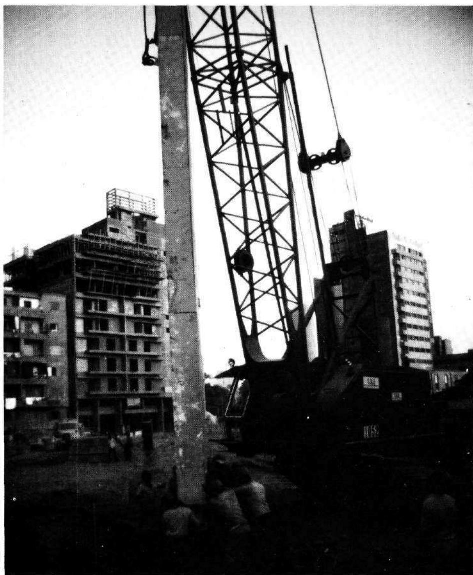
Mise en place du premier panneau.
