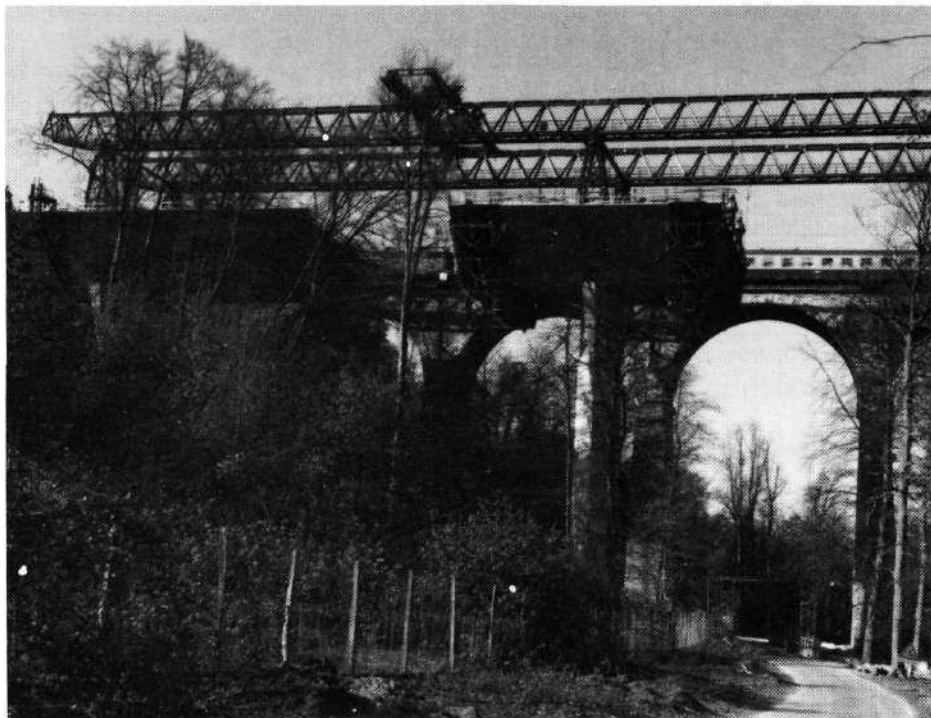
Fléau en construction et bi-poutre de manutention.
