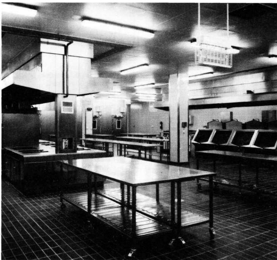
Bâtiment "Catering". Cuisines.
