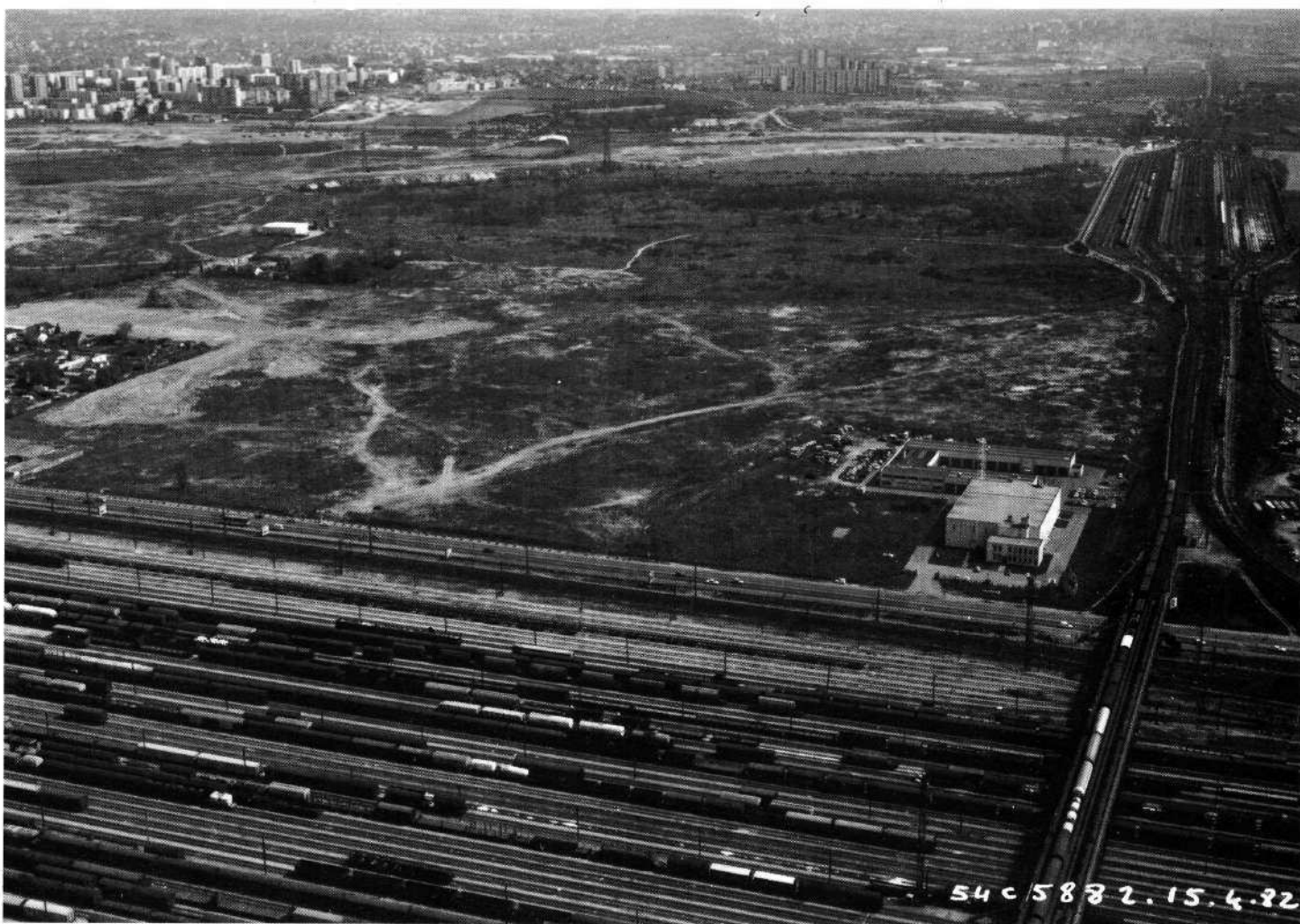
Terrains d'implantations de la station de Valenton.
