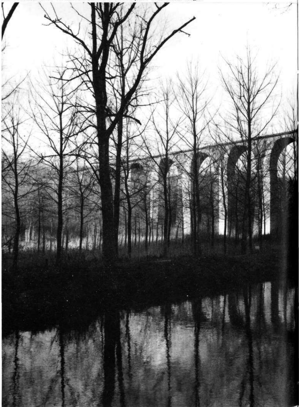
Franchissement du Vallon de Commelles par l'ancien ouvrage.
