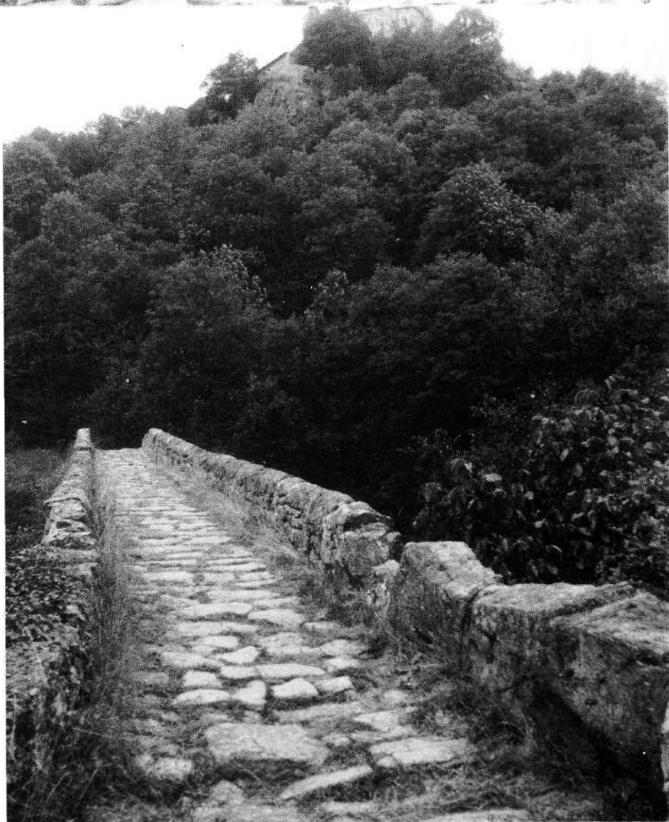
Voie romaine ornierée afin d'assurer le guidage des véhicules dans les rampes et les pentes, à l'oppidum d'Ambrussum (Hérault).
