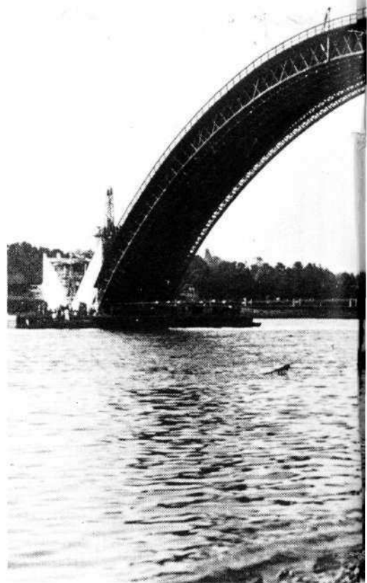
Pont sur l'Elonn (arches en béton armé et tablier métallique. Société Limousin 1930)
