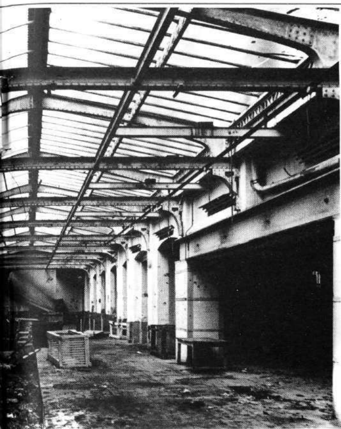
Fabrique de laine cardée des établissements Blin & Blin à Elbeuf. Un espace en cours de reconversion : 175 logements, 10 000 m 2 d'artisanat, commerce, petite industrie. La maîtrise d'ouvrage est confiée à l'O.P.A.C. de Seine-Maritime Reichen & Robert, architectes
