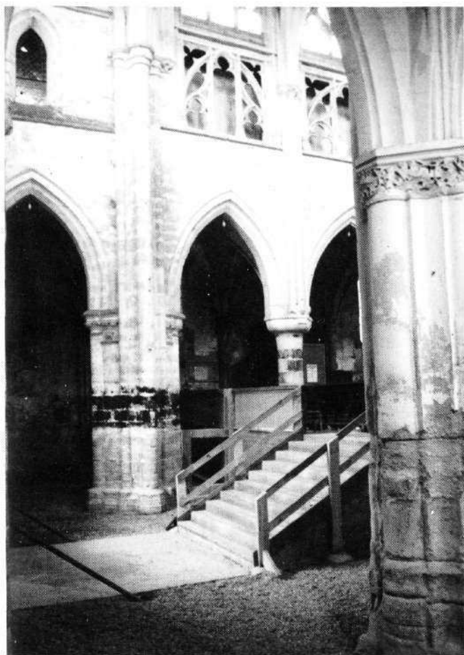
La nef avec les deux premières travées dégagées.
