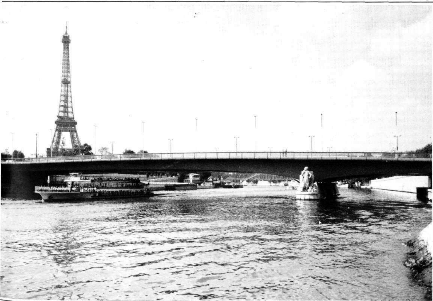
Photo H. Baranger
