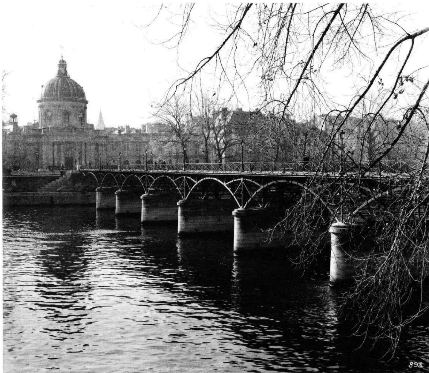
Photo H. Baranger
