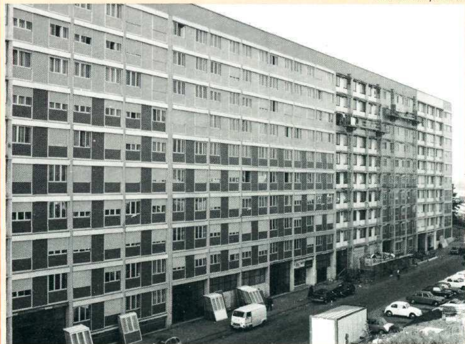
Façade terminée à gauche et en cours de travaux à droite
