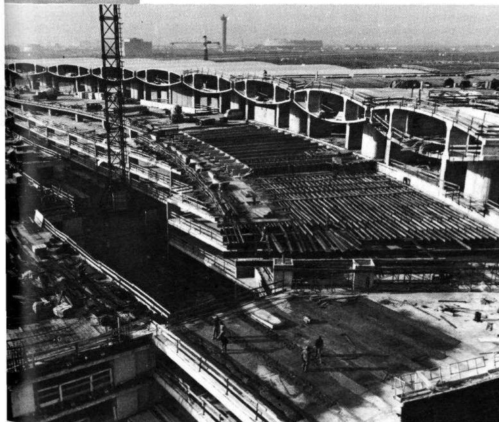
4 - Roissy II : Préfabrication lourde ; noter les 9 éléments de toiture en béton léger servant de locaux techniques.
