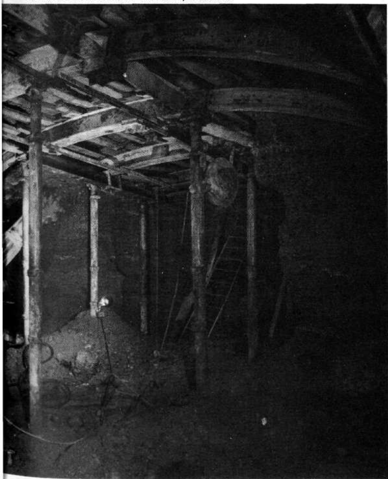
Fig. n° 6 — Terrassement d'un abattage dans les alluvions à l'aide d'une machine ponctuelle.
