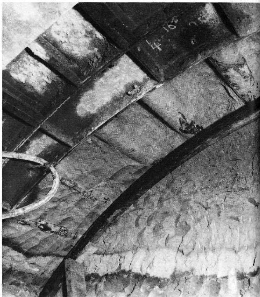
Fig. n° 9 — RER - Ligne A. Pose d'un cintre sous les tubes de soutènement.
