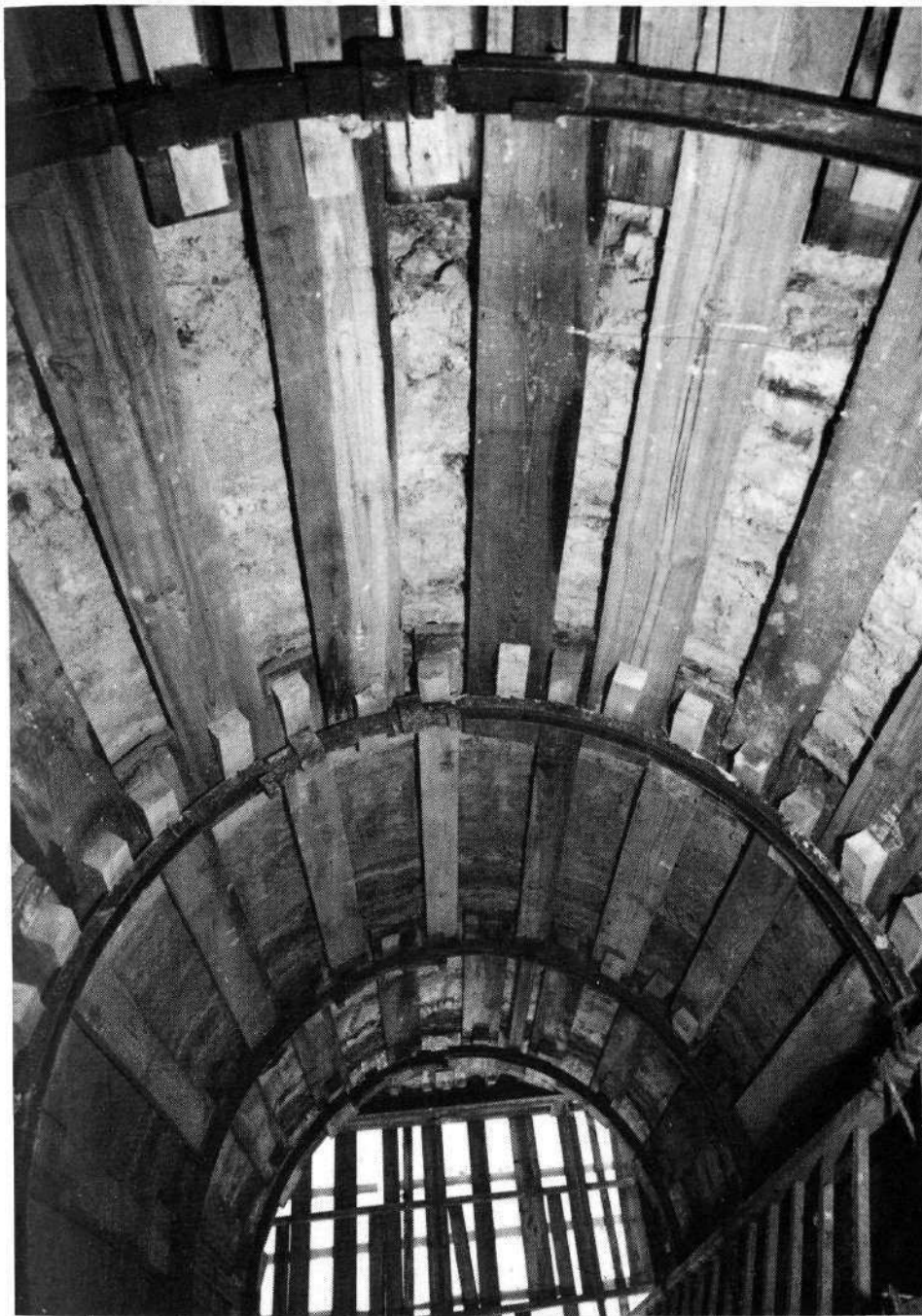
Fig. n° 3 — Puits de reconnaissance du sol.
