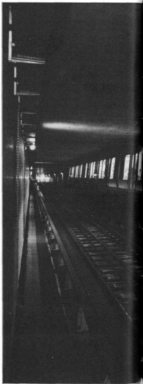
La rame en Tunnel
