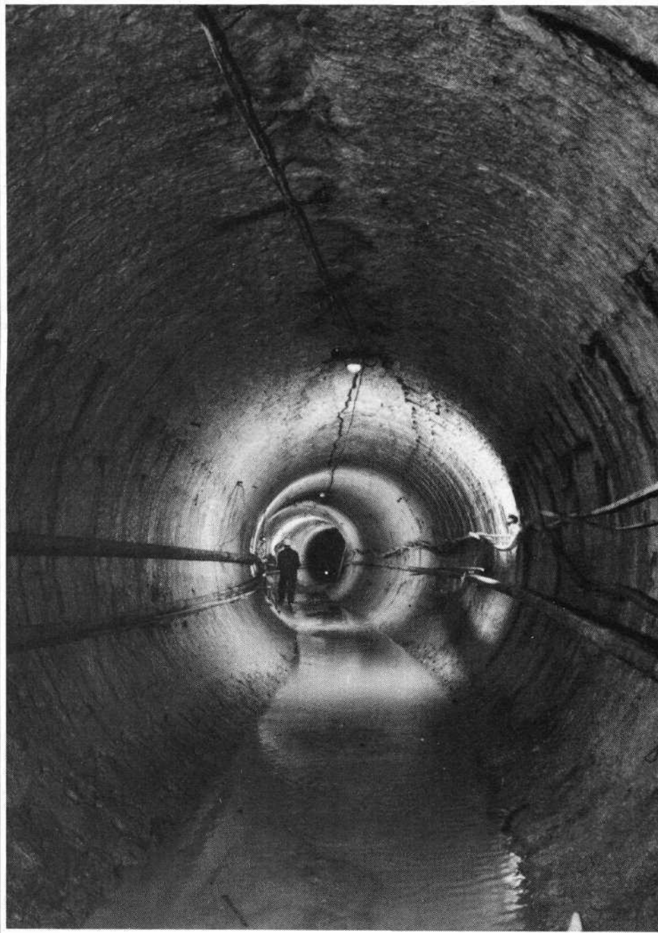
Fig. n° 4 — RER - Ligne A - Section Auber-Châtelet Galerie de reconnaissance exécutée avec une machine à forer.
