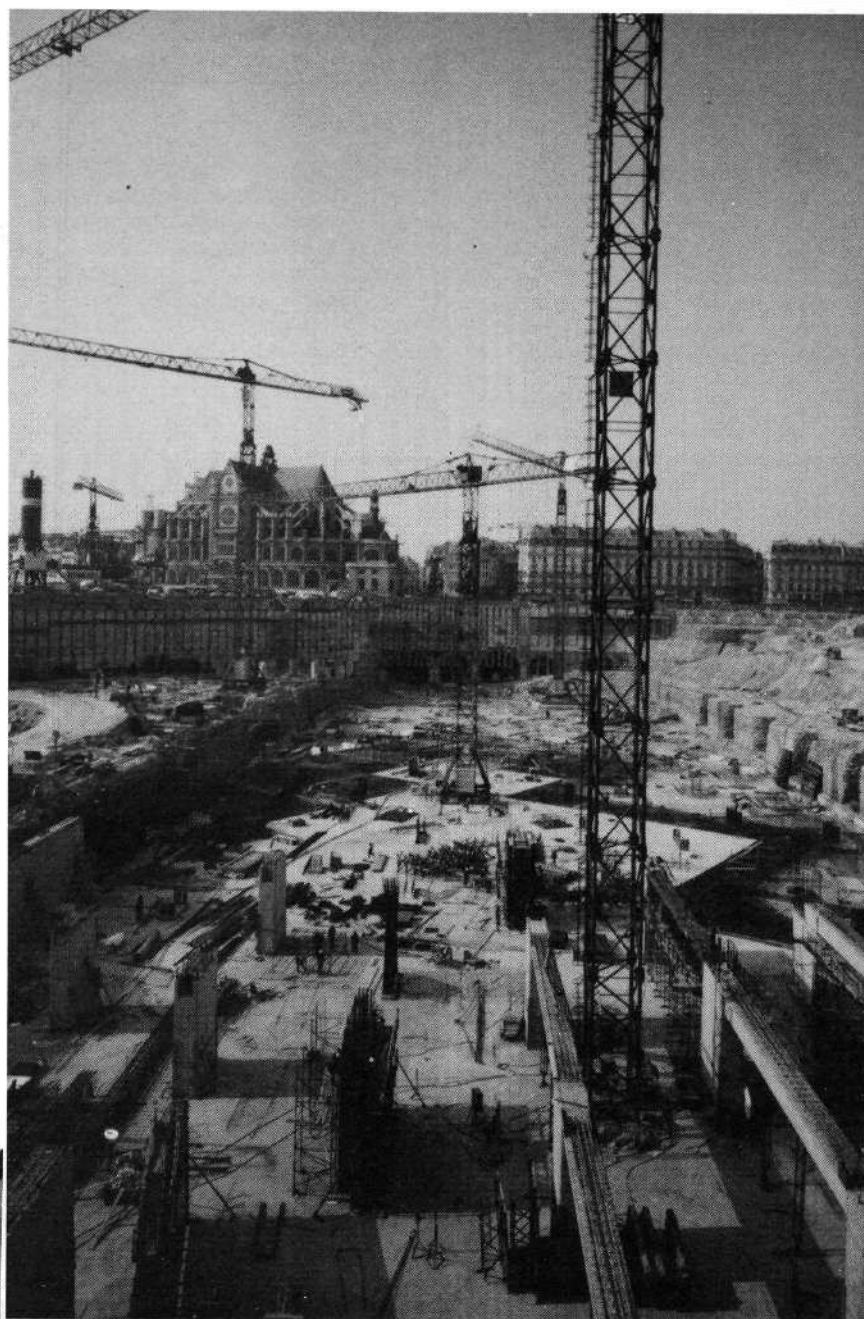
Construction de la gare de Châtelet-les-Halles (fouille à ciel ouvert).
