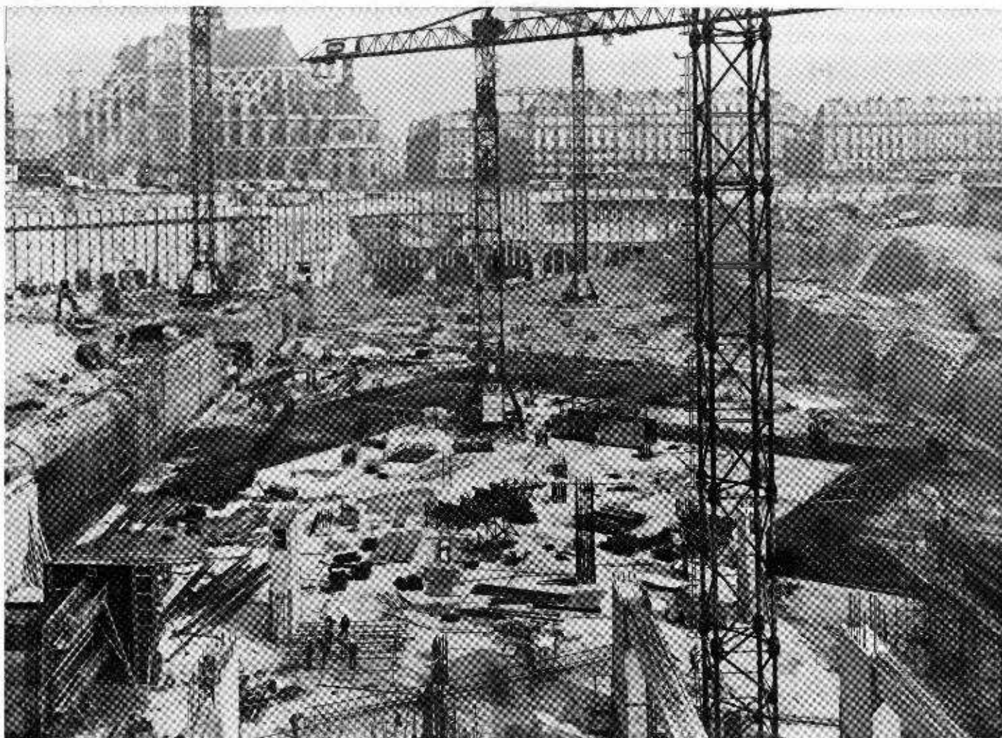
Fig. n° 7. — Vue d'ensemble du chantier le 21 avril 1975.
