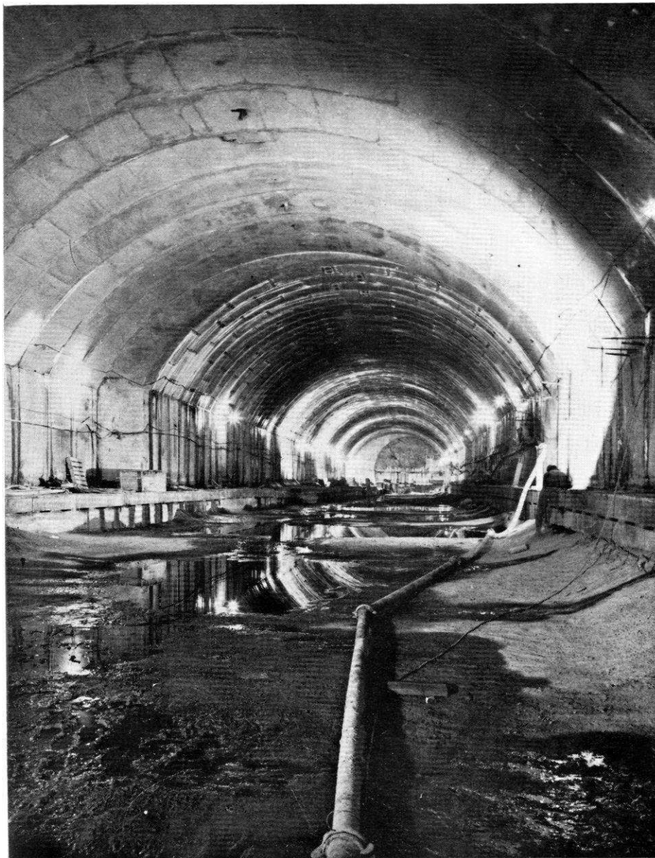
Fig. N° 3. — Ligne B. - Châtelet - Gare du Nord.
