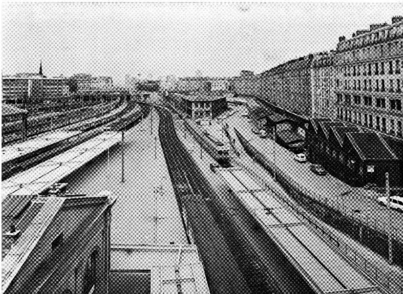
Photo n° 2. — Vue générale de la partie de la gare du Nord où doit se construire la gare souterraine. Au premier plan, la gare provisoire « Roissy » et à l'arrière-plan les halles qui doivent disparaître. (Photo Billerach).
