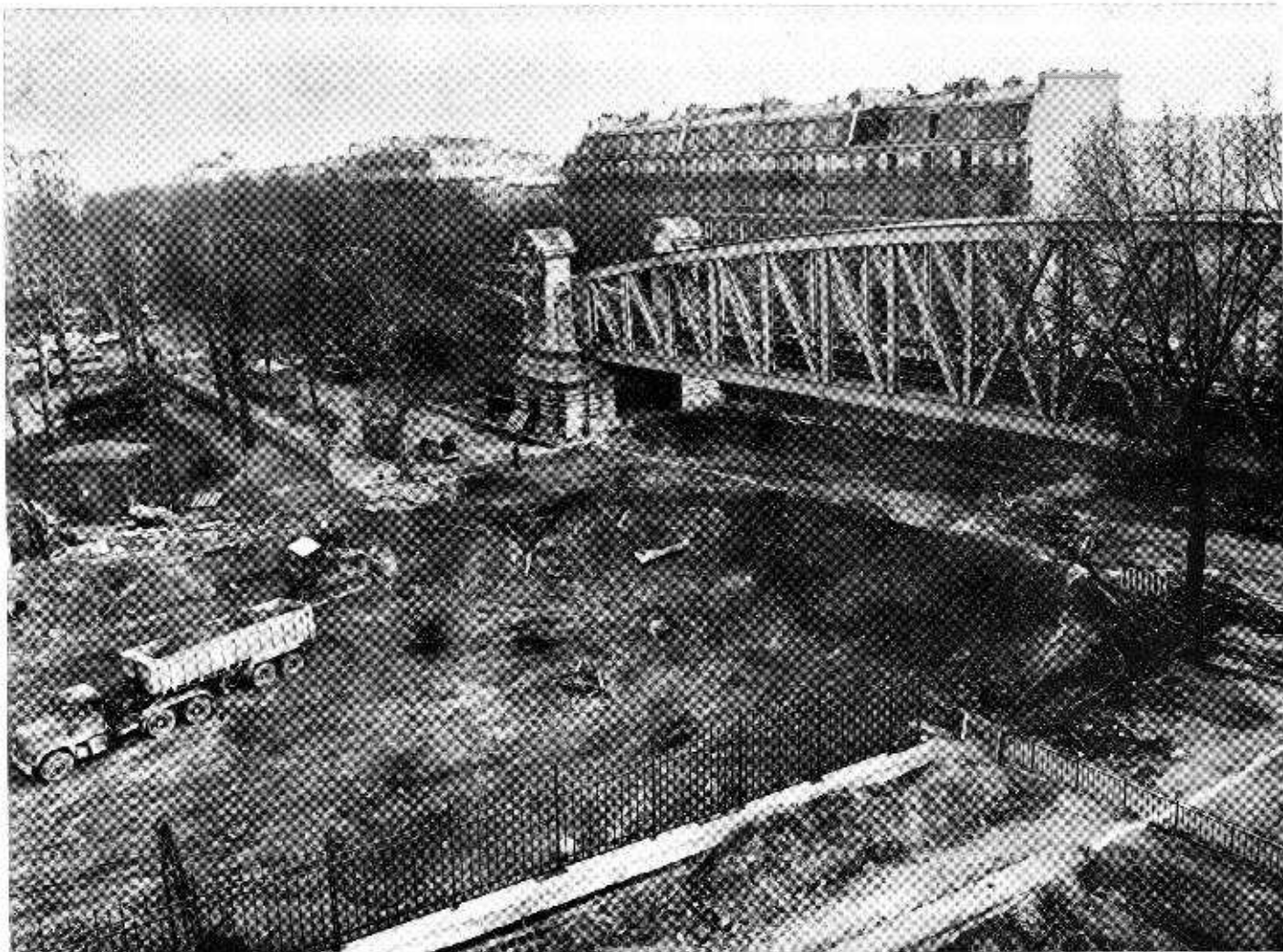
Photo n° 5. — Boulevard de la Chapelle. Début des travaux de terrassement à l'emplacement de la chaussée Nord interrompue provisoirement. Au second plan, à droite, le viaduc du métro aérien dont la grande portée permet d'en éviter la reprise. (Photo Billerach).
