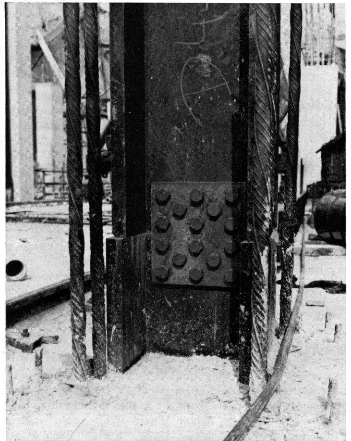
Fig. n° 6. — Ouvrage principal. Vue d'un poteau et de son profilé métallique.
