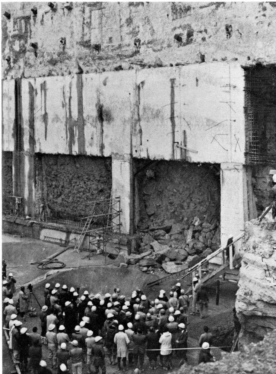
Fig. n° 6. — Arrivée de la machine à forer dans la fouille Le Châtelet - Les Halles.
