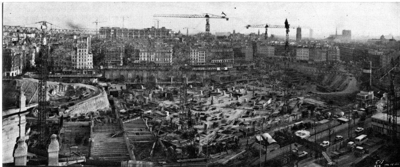
Vue générale du chantier.
