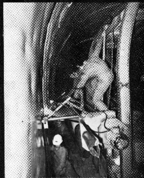
3) Soudure à la flamme du L2 PV2 sur non tissé accroché à la voûte
