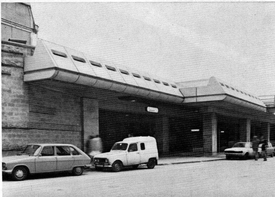
Fig. n° 7. — Ouvrage principal vu de la rue de Bercy.
