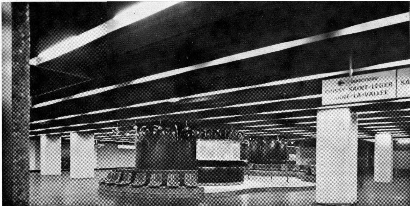
Fig. n° 8. — Ouvrage principal. Vue au niveau des quais R.E.R. « Gare de Lyon ».
