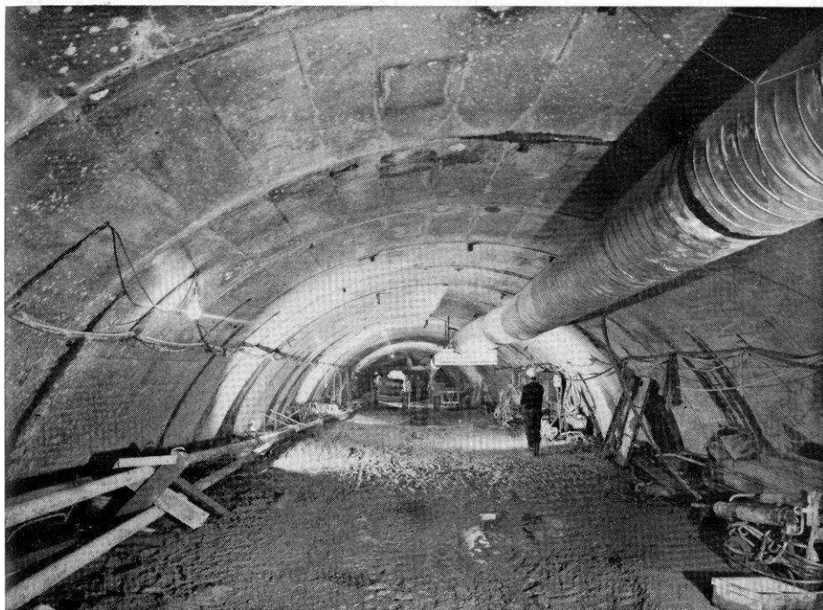
Fig. n° 2. — Tunnel de 8,70 m d'ouverture
