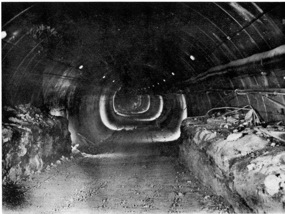
Fig. n° 2. — Lot 2. Tunnel de 8,70 m d'ouverture.
