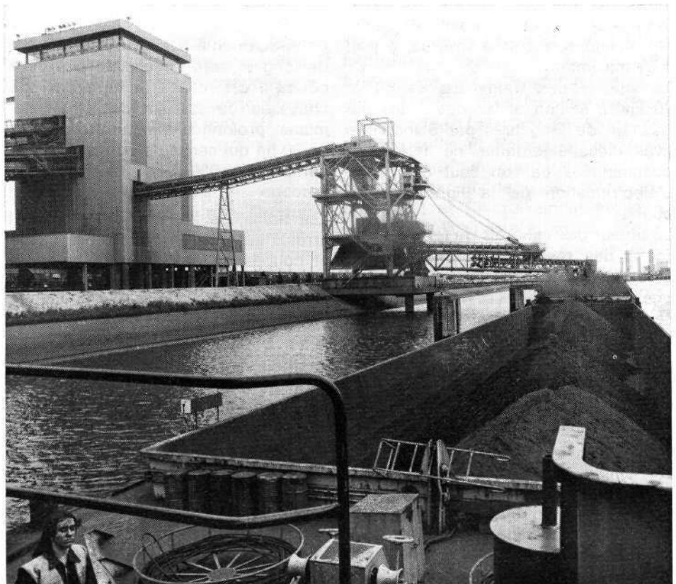
Engin de rechargement sur barge à Mardyck
