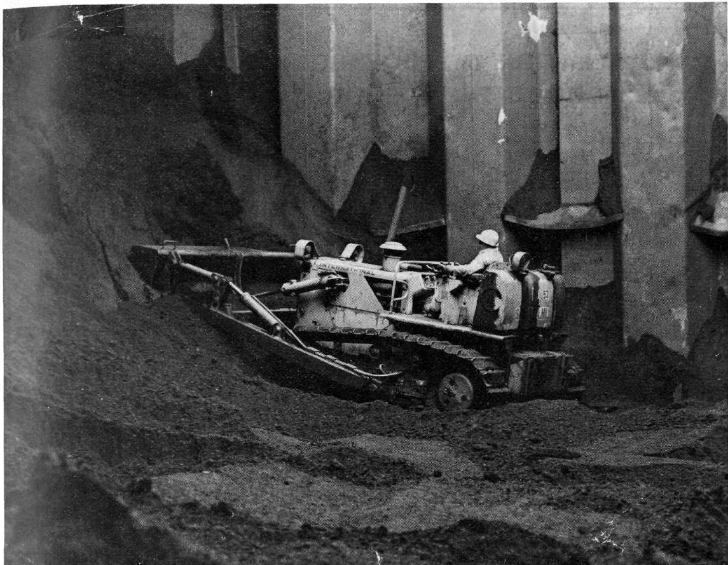
Travail de bulldozer en cale
