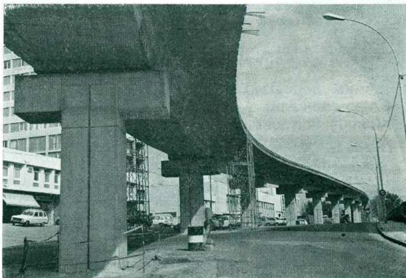
Métro de Marseille (en participation). Viaduc de la Rose (exécution Moinon).
