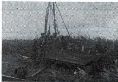
Sondages en zone marécageuse
