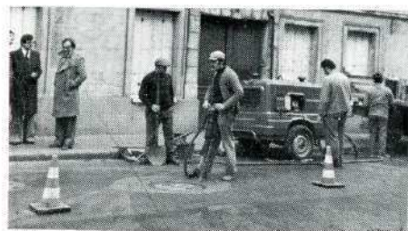
8 h 30 : Début de chantier.
