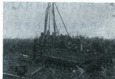
Sondages en zone marécageuse
