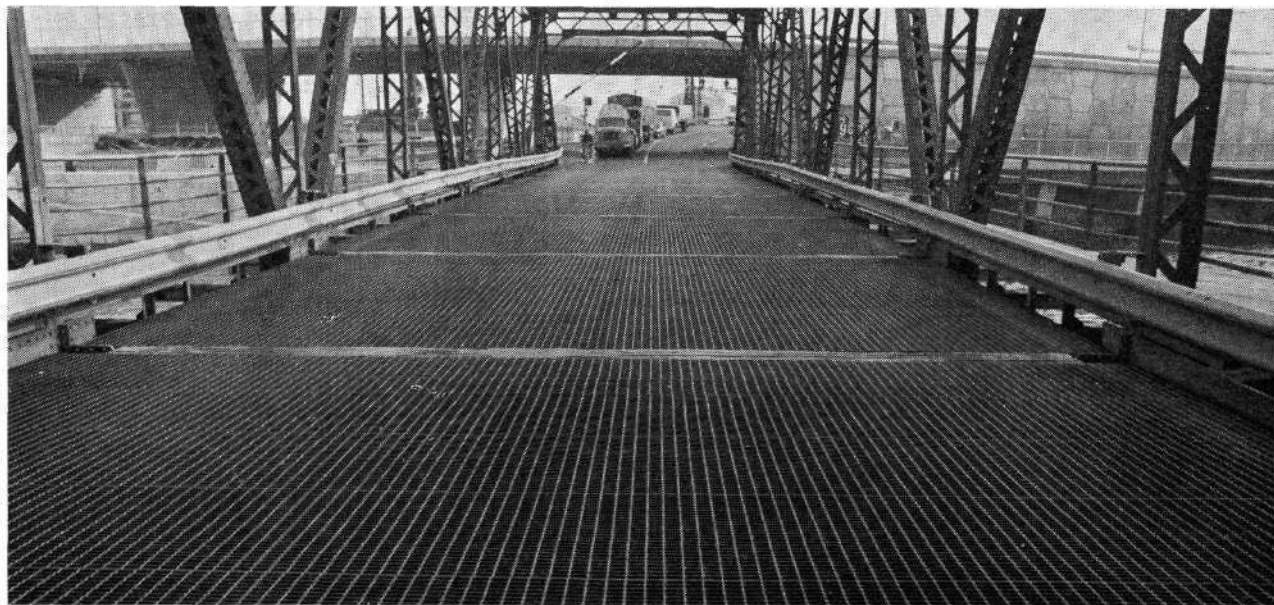
Pont-route à Sète (34)
