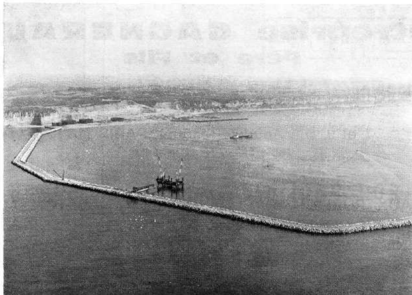
Terminal pétrolier - Le Havre - Antifer.
