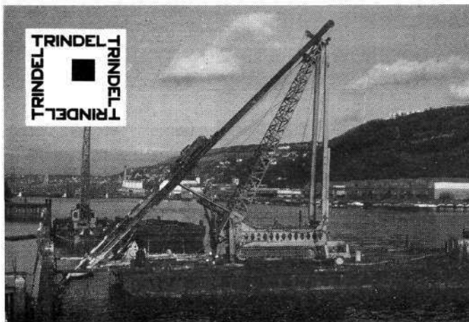
Battage d'un pieu à 45°
