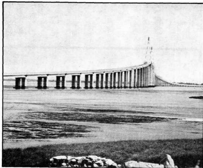
Pont St Nazaire St Brévin
