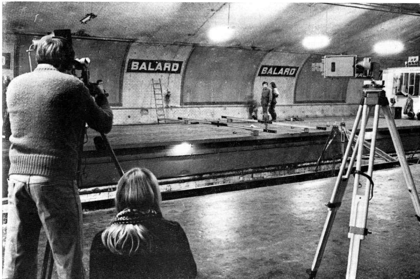
Contrôle photogrammétrique des profils d'une station de métro.
