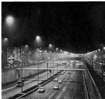
Autoroute A1 - Après le passage Diderot en direction du passage du Landy-Paris-Provence
