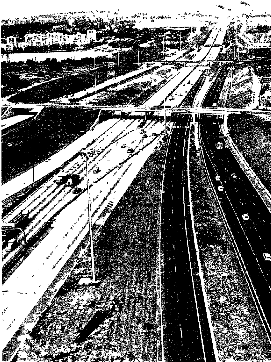
Doublement de l'autoroute du Sud
