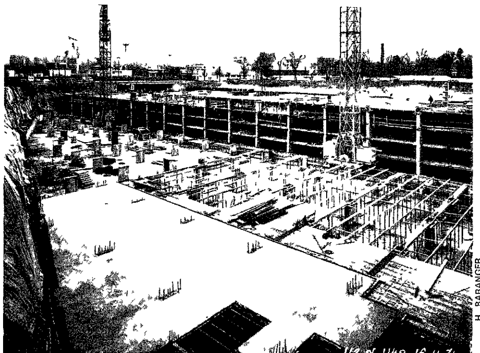
Chantier du parc de la Porte d'Auteuil. Capacité 1.600 places
