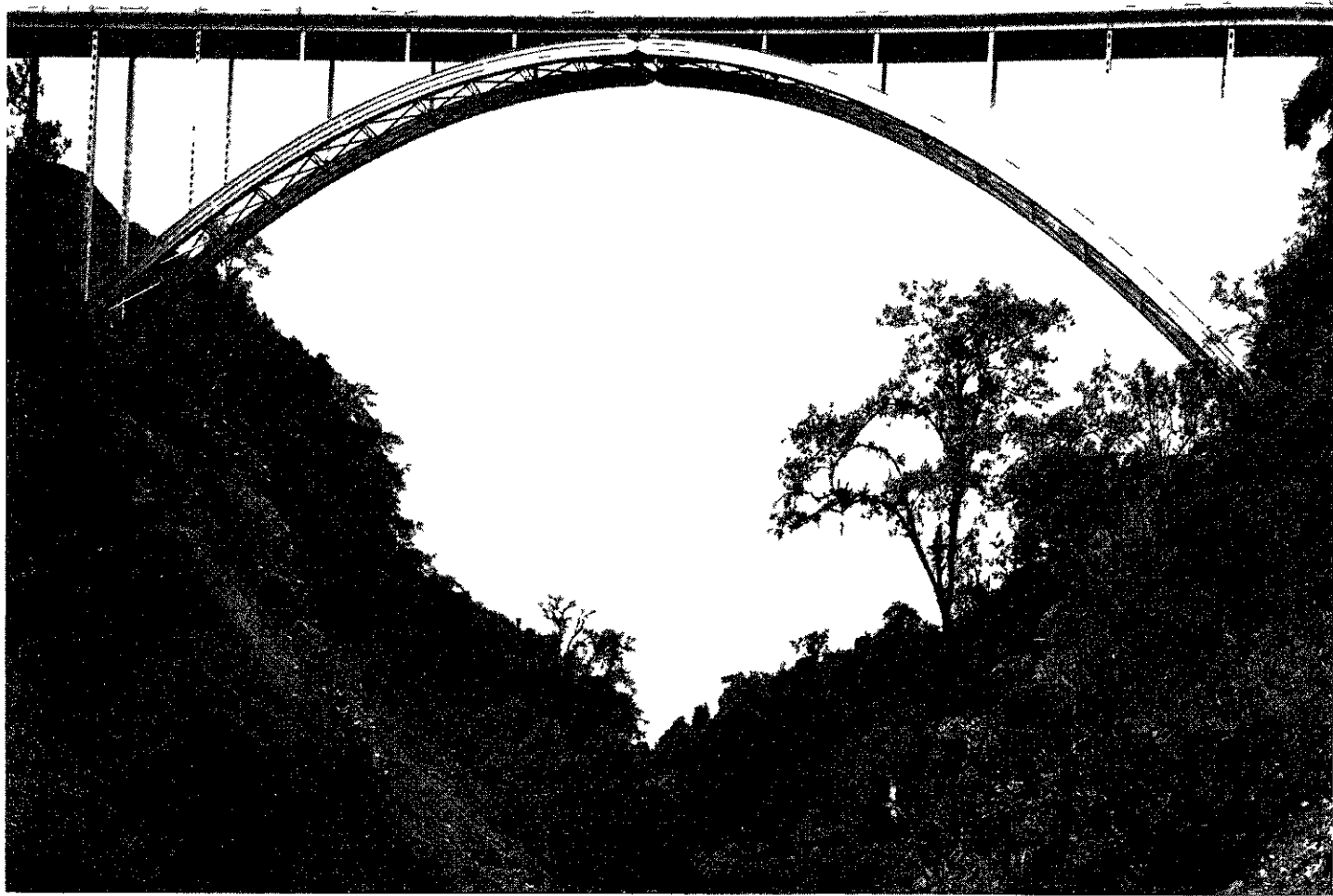
Pont en arc a SALSIPUEDES (Equateur)
