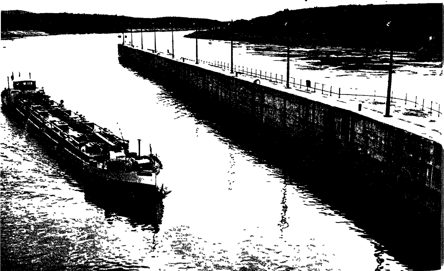
Aménagement du Rhone, novembre 1961 — Barrage de Chateaufort-du-Rhône (Drôme)
