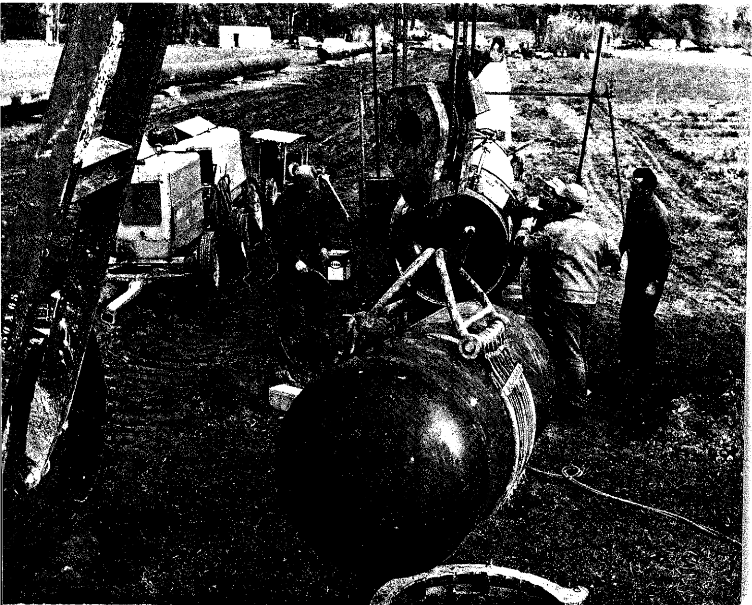
Pipe-line Sud Européen
