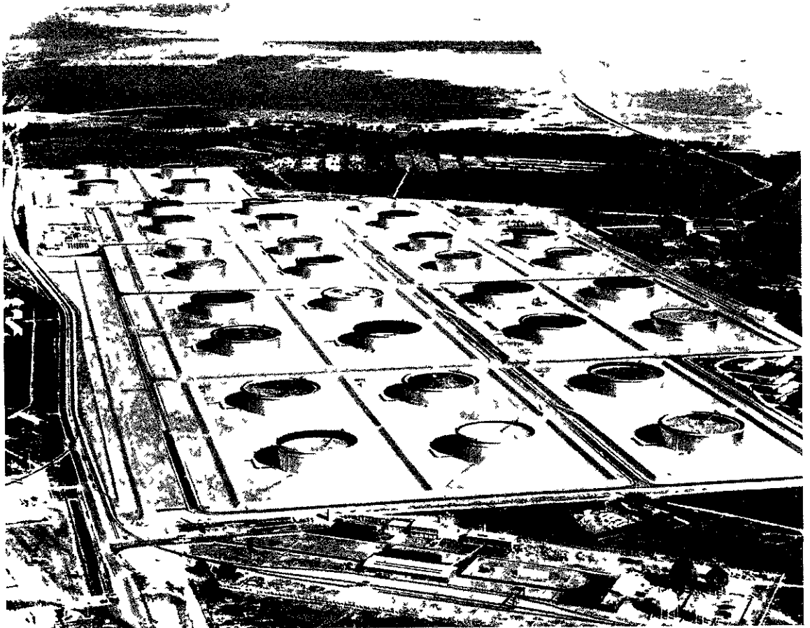
Parc de stockage du pipe-line Sud-Européen - Fos-sur-Mer (Photo Alain Perceval)
