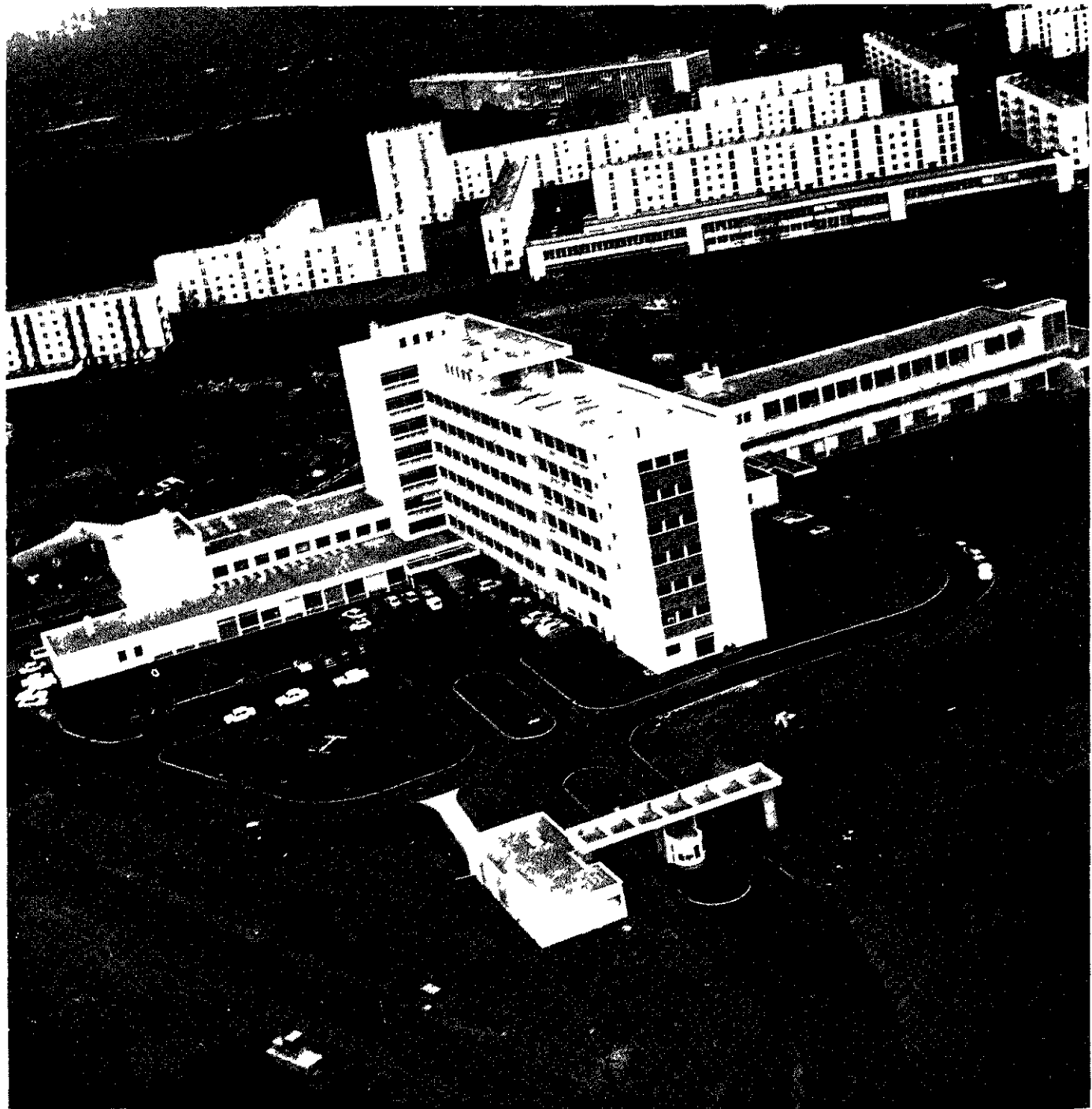
Vue générale du nouvel hôpital de Poissy-sur-Seine
