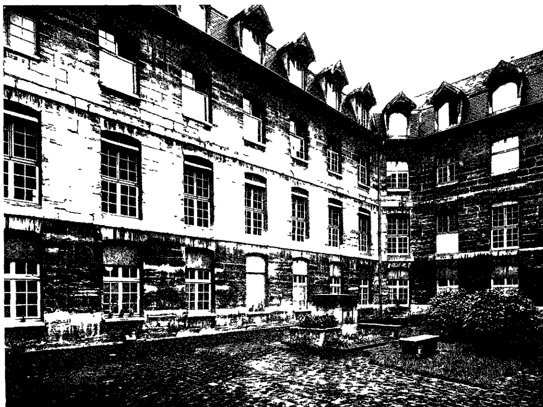
Une vue de la Salpêtrière : Faut-il moderniser ou reconstruire ?
