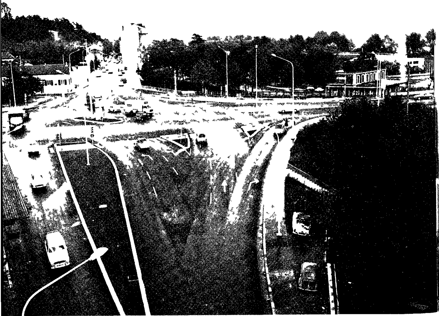
CARREFOUR POINCAÏE RIVE DROITE — Vue d'ouest en est sur les passages supérieurs de St Clément
