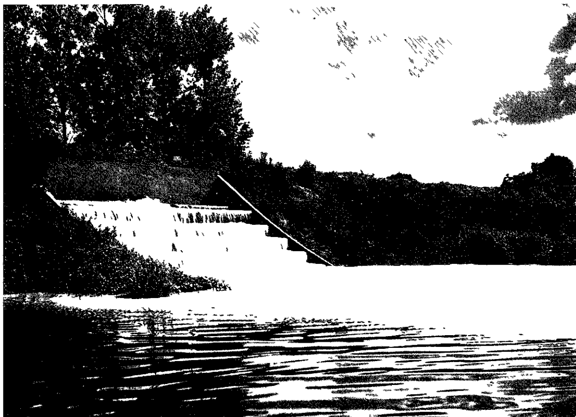
Cascade d'alimentation d'un bassin d'infiltration
